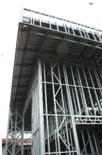
Figura 1.3 - Painel com contraventamento em treliça vertical.
