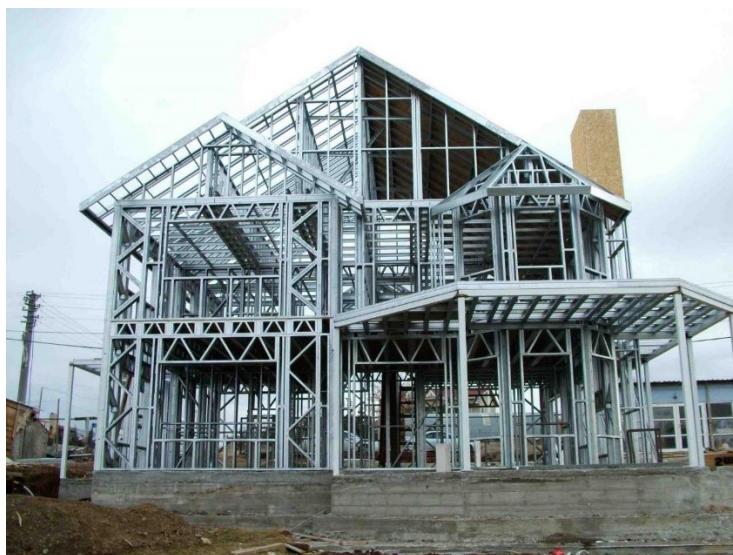
Figura 1.1 - Residência no Sistema Construtivo LSF. Fonte: Full Estruturas, 2016.
