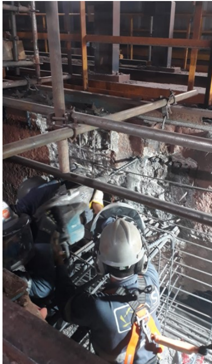
Figura 6 – Fixação de armaduras novas com ancoragem
