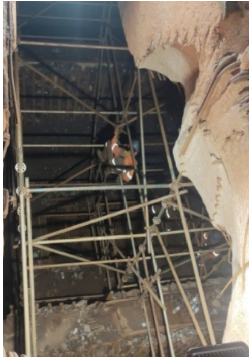
Figura 4 – 1ª etapa da obra: Montagem de andaime
