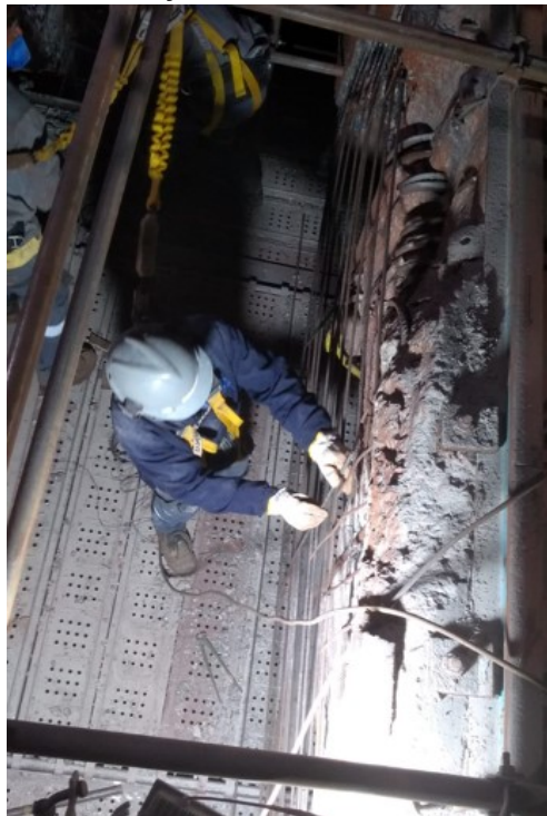
Figura 5 – Escarificação do restante do concreto danificado
