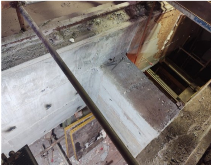
Figura 8 – Finalização da obra: desforma de viga revitalizada
