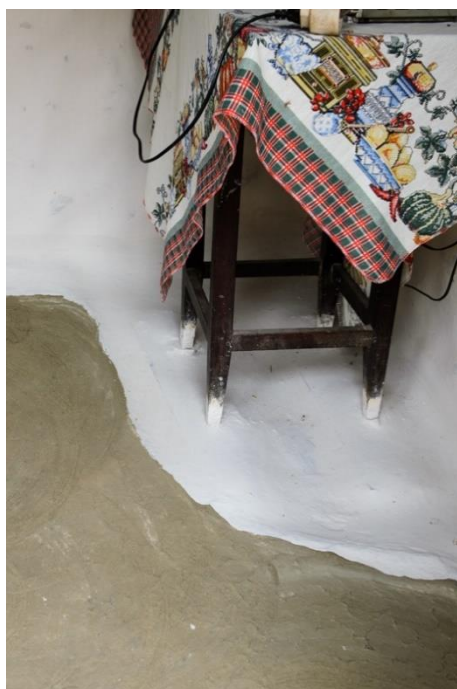
e) Piso e paredes recém pintados
