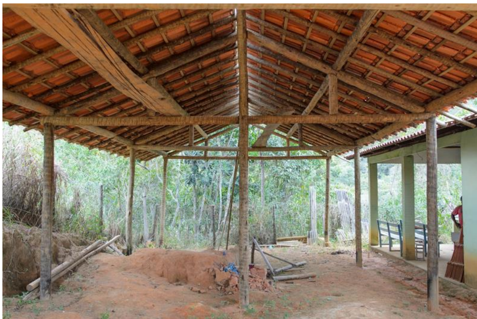
Figura 76 – Obra da casa de farinha da comunidade do Indaiá
