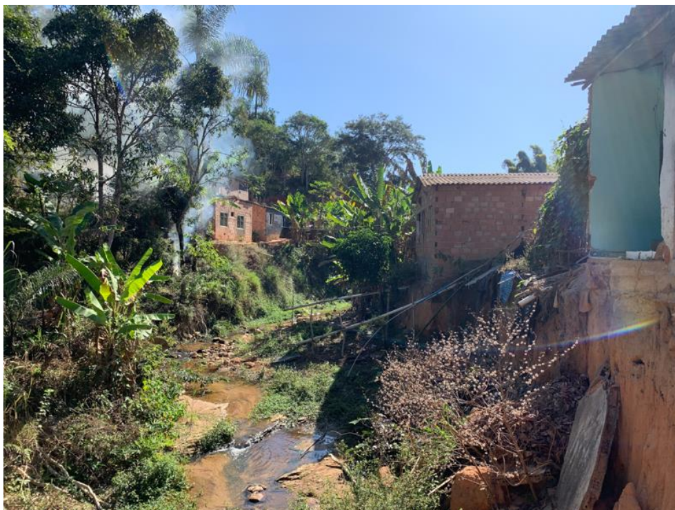
Figura 46 – Córrego Boa Vista e casas atingidas pela enchente
