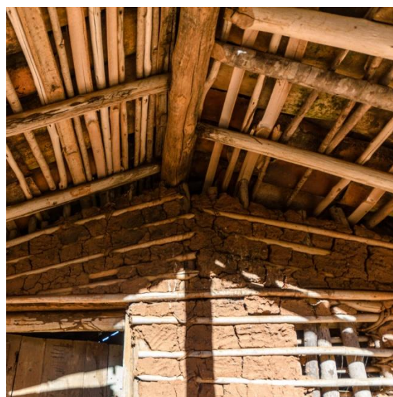
Figura 83 – Detalhes superior e inferior da cobertura com telha de cumbuca
