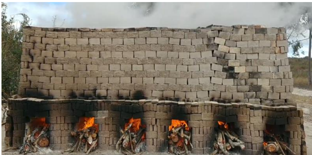
Figura 123 – Exemplo de caieira para queima de tijolos (região Nordeste, local não informado)
