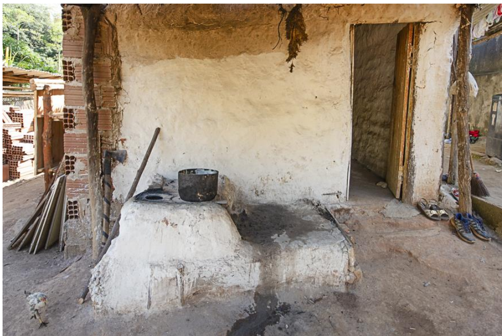
Figura 56 – Fogão à lenha revestido com barro branco, residência da Dona Maria Perpétua: comunidade do Indaiá
