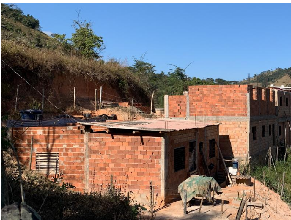
Figura 121 – Residência em alvenaria de tijolo furado: comunidade do Boa Vista
