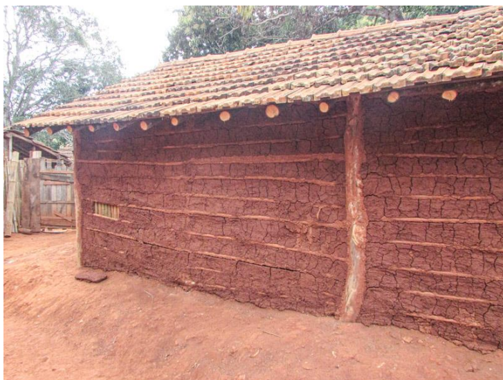
Figura 86 – Construção em pau a pique: comunidade Saco do Barreiro
