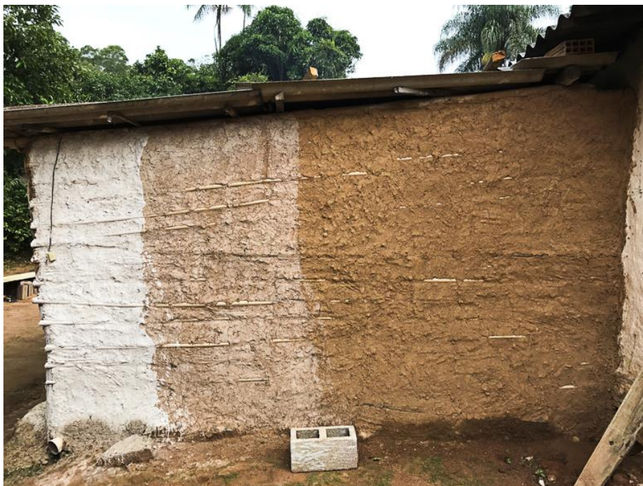
Figura 55 – Processo de manutenção das paredes da casa da Dona Fatinha: comunidade do Indaiá
