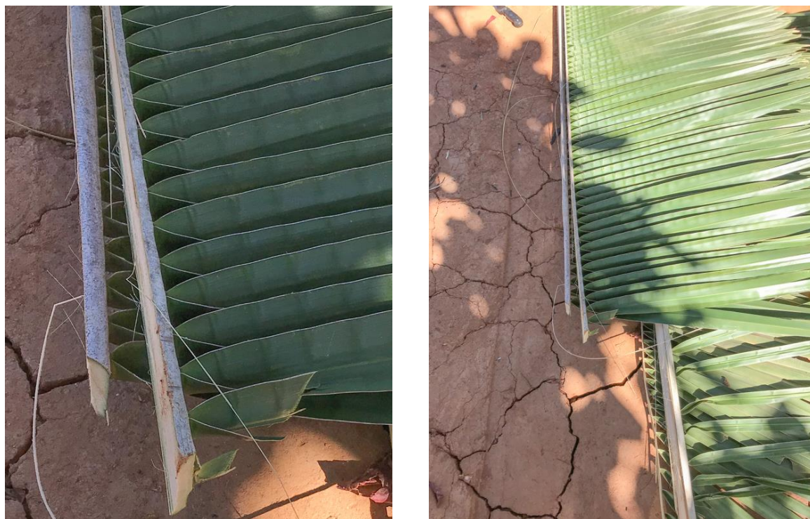
Figura 135 – Demonstração de sobreposição das folhas de indaiá para construção de uma cobertura
