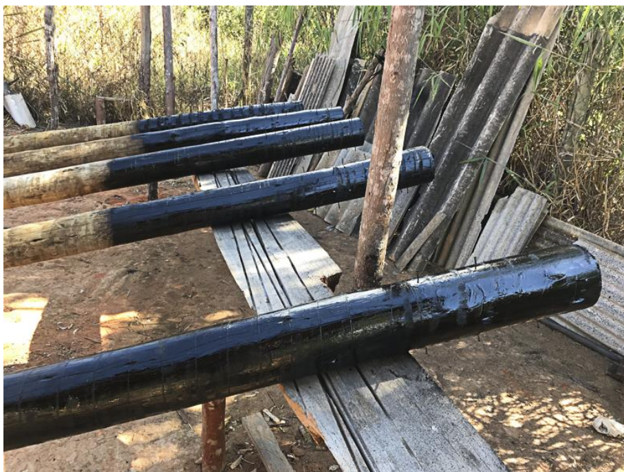
Figura 8 – Processo de impermeabilização da estrutura de eucalipto tratado
