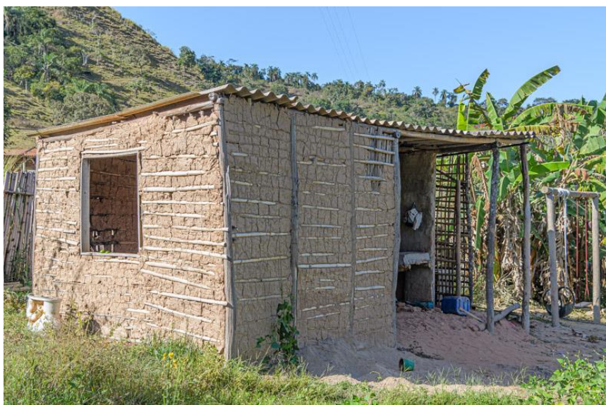
Figura 85 – Construção recente em pau a pique ao lado da comunidade Boa Vista
