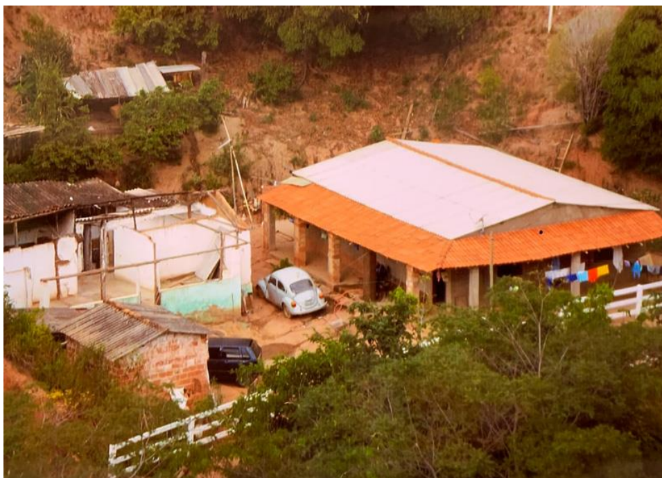
Figura 100 – Processo de demolição da antiga casa de Dona Geralda, comunidade do Macuco
