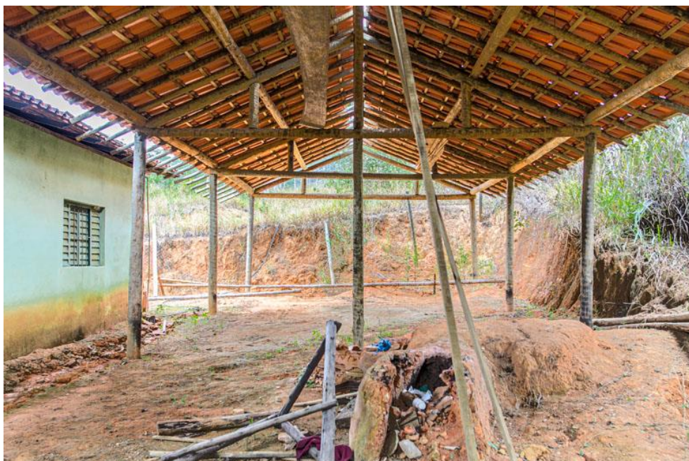
Figura 134 - Obra da casa de farinha, comunidade do Indaiá
