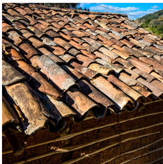
Figura 83 – Detalhes superior e inferior da cobertura com telha de cumbuca
