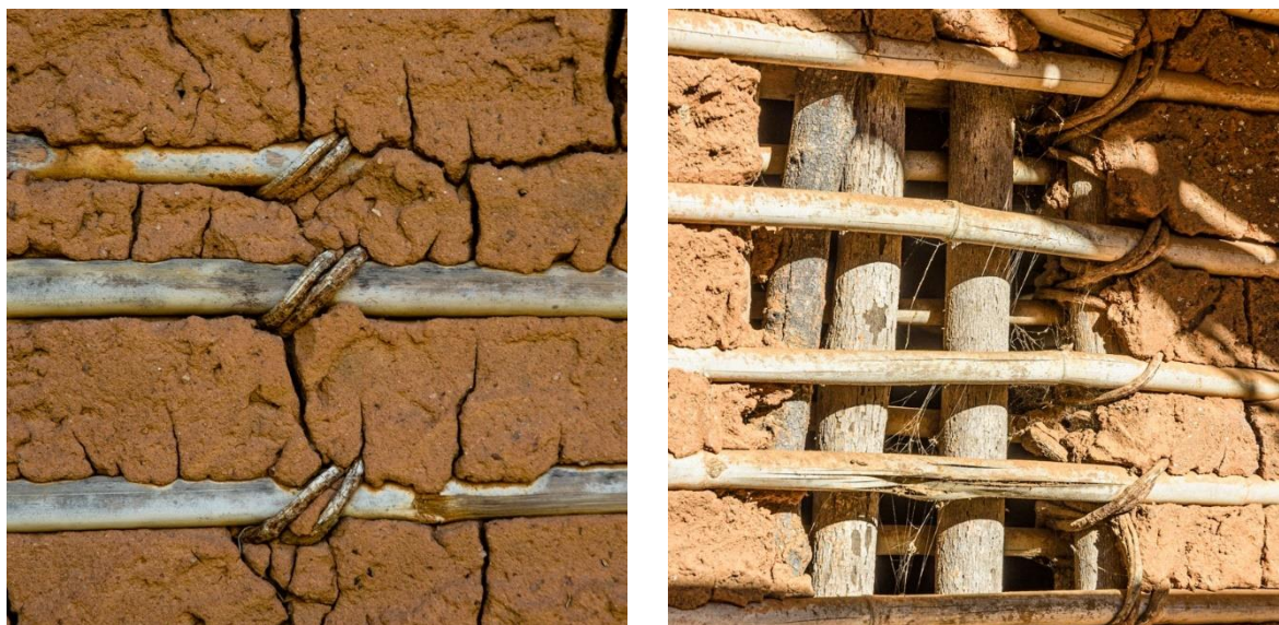
Figura 84 – Detalhes da trama: amarrações feitas com cipó
