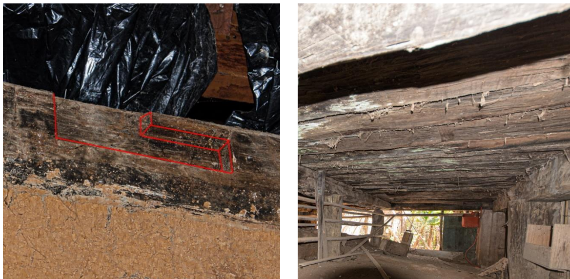
Figura 71 – Entalhe na viga para travamento do forro e vista inferior do piso da senzala que restou
