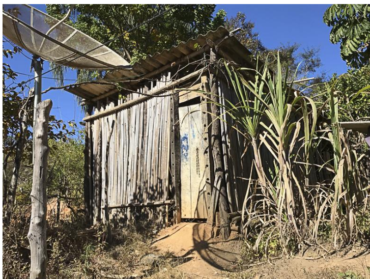
Figura 96 – Construção provisória sem o revestimento em barro: Seu Nonô e Dona Fia, comunidade do Indaiá
