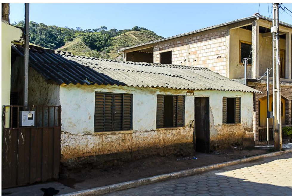
Figura 125 – Casa do Senhor Sebastião Hilário, construída com adobe e tijolo queimado, comunidade do Barro Preto
