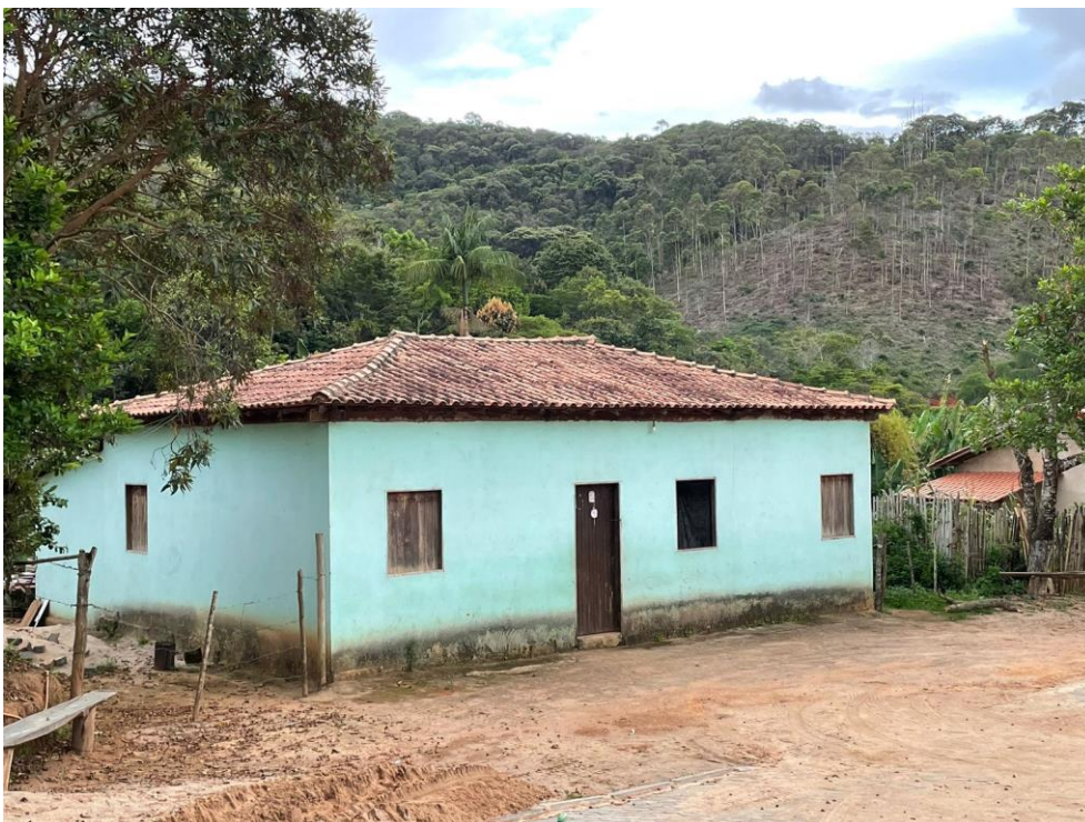
Figura 98 - Atual casa do Seu Nonô e Dona Fia, construída em alvenaria de tijolo furado: comunidade do Indaiá
