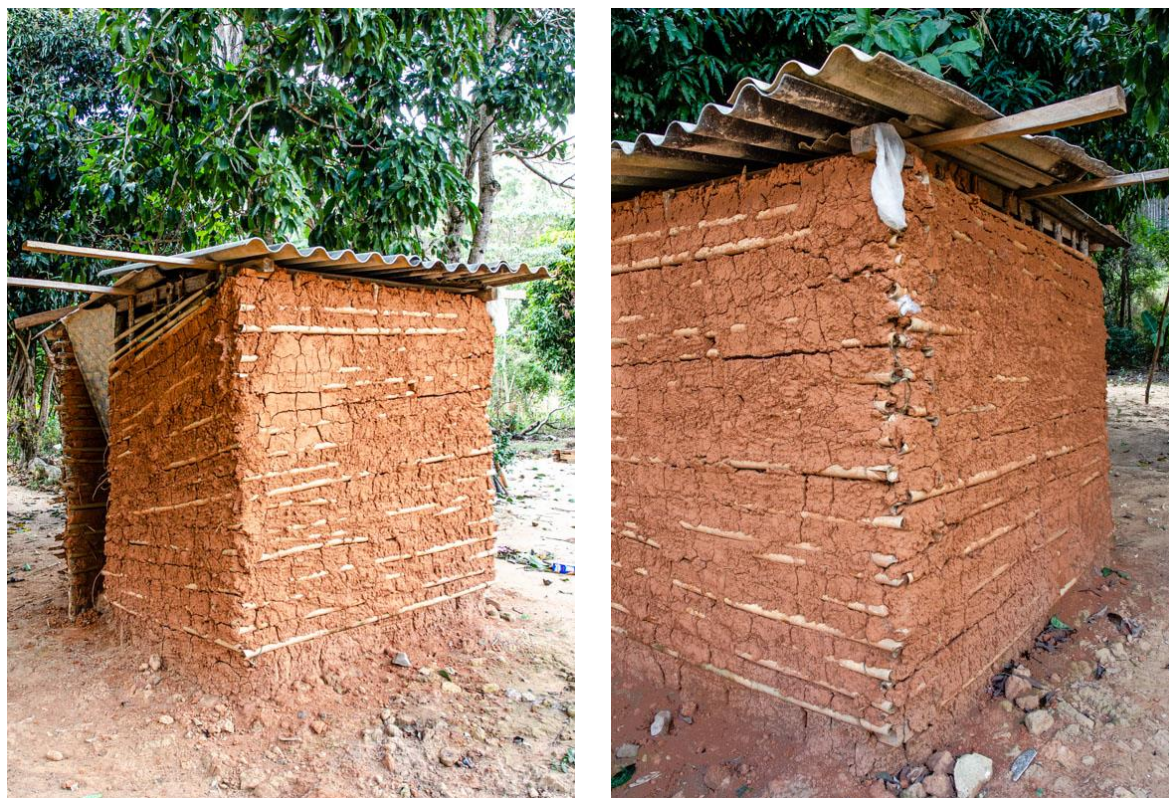
Figura 103 – Sanitário externo: comunidade do Indaiá
