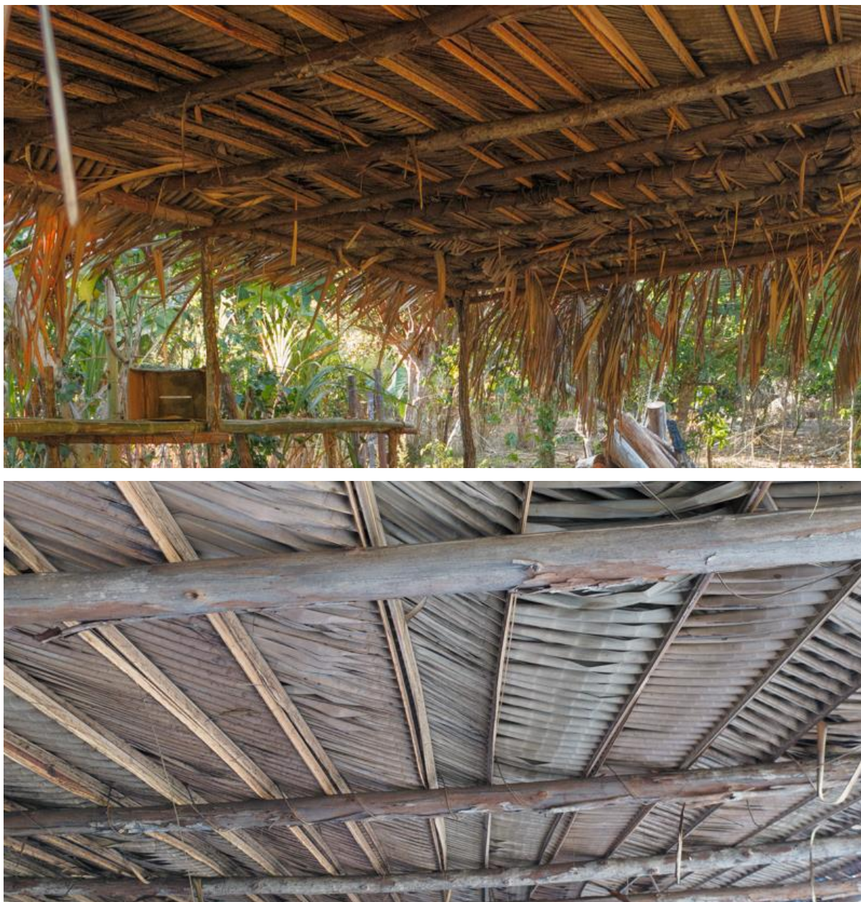
Figura 136 – Cobertura feita com folha de indaiá: visão geral e detalhe. Comunidade do Indaiá
