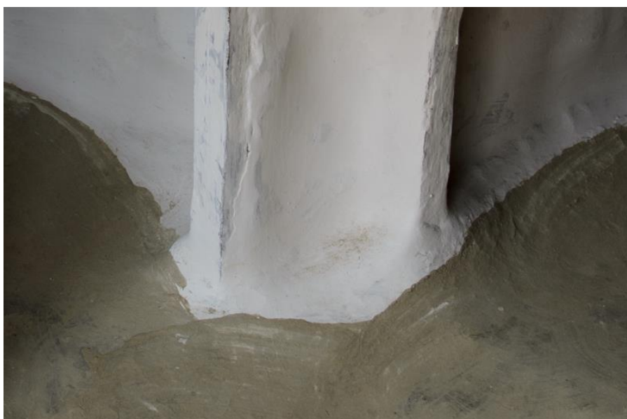
Figura 57 - Aplicação do barro branco em paredes internas; e aplicado no piso misturado ao estrume de gado para atingir a coloração verde. Casa da Dona Fatinha: comunidade do Indaiá
