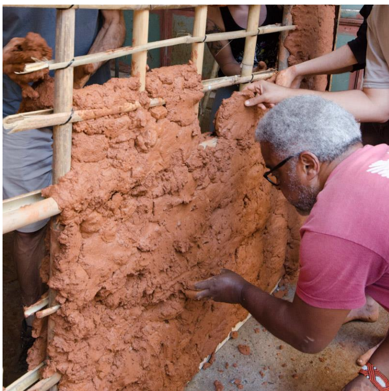
Figura 54 – Pau a pique – processo de barreamento: oficina sobre técnicas de construção em terra, UFMG
