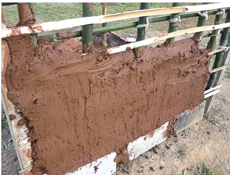
Figura 105 – Parede de pau a pique em oficina de construção em terra da Escola de Arquitetura da UFMG
