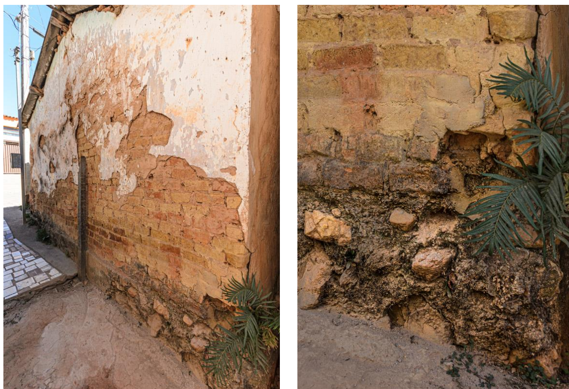
Figura 127 - Casa do Seu Sebastião Hilário: fundação e parede lateral direita
