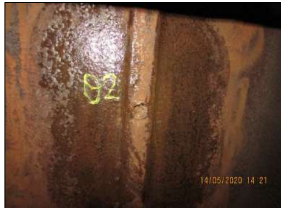
Figura 10 - Ensaio de ultrassom na junta central na chapa de tabuleiro.
