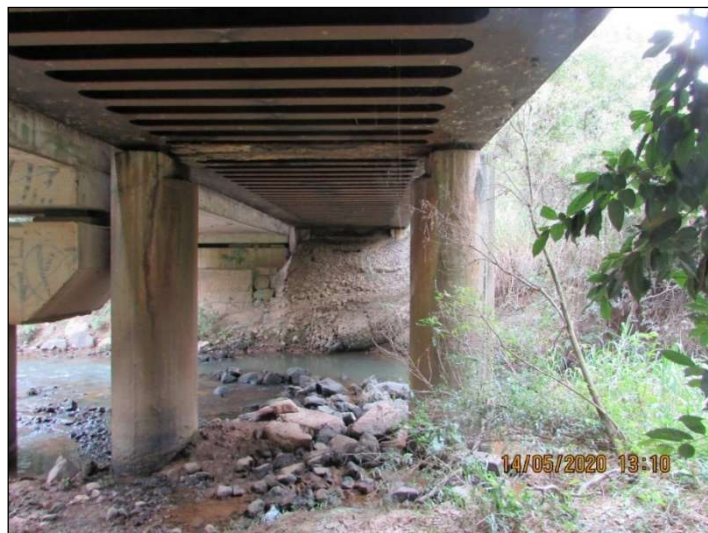
Figura 2 – Vista inferior da ponte e mesoestrutura.
