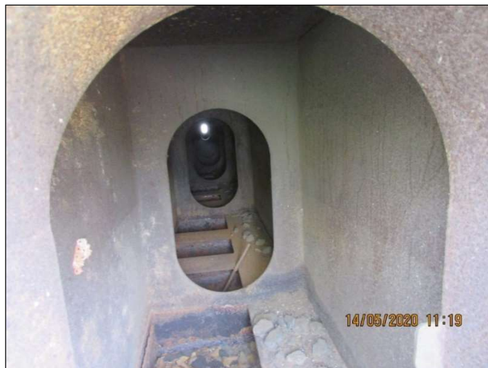
Figura 4 – Vista interna da viga caixão.
