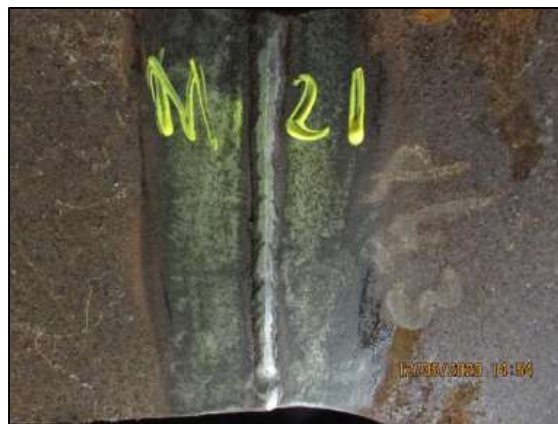
Figura 9 - Ensaio de ultrassom na junta transversal de mesa inferior da transversina, na extremidade.
