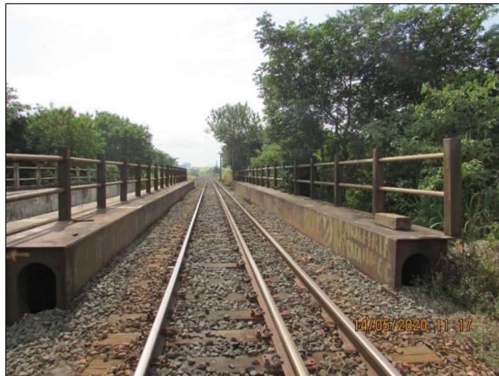
Figura 1– Vista Superior da ponte.
