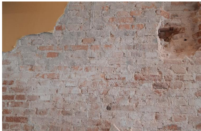
Figura 7 – Demolição de camadas de revestimento argamassado e acabamento.
