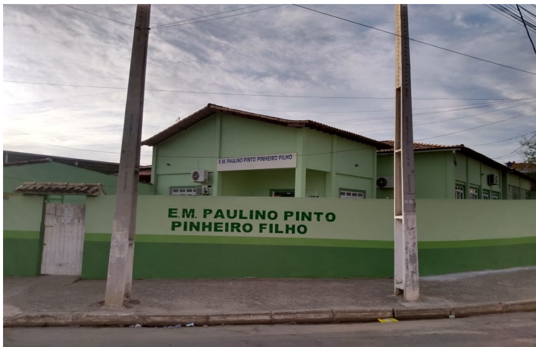
Figura 3 - Fachada da Escola Municipal Paulino Pinto Pinheiro Filho
