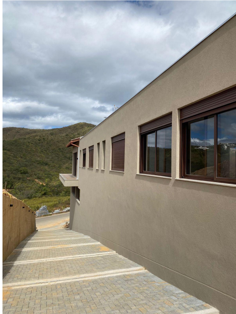
Figura 11: Rampa/ Fachada Lateral Direita da residência em fase atual de construção
