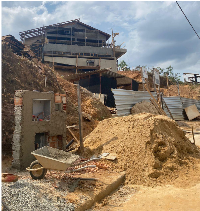
Figura 6: Fachada da residência em construção
