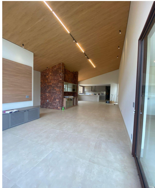
Figura 10: Sala integrada com cozinha da residência em fase atual de construção
