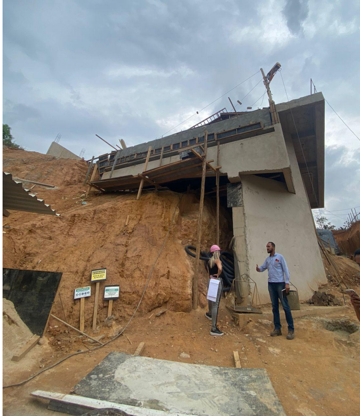
Figura 7: Fachada da residência em construção
