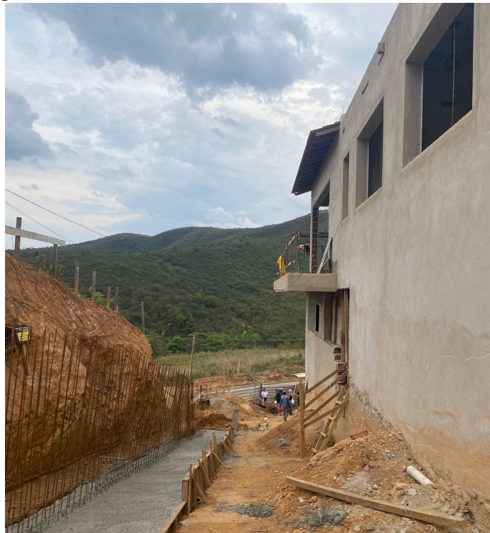
Figura 8: Fachada lateral da residência em construção
