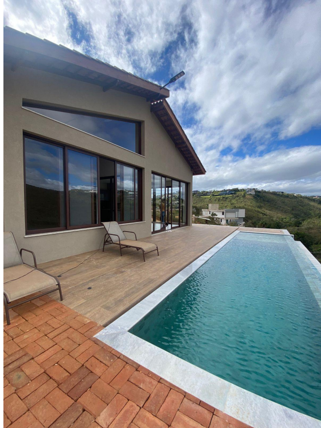
Figura 9: Fachada frontal da residência em fase atual de construção
