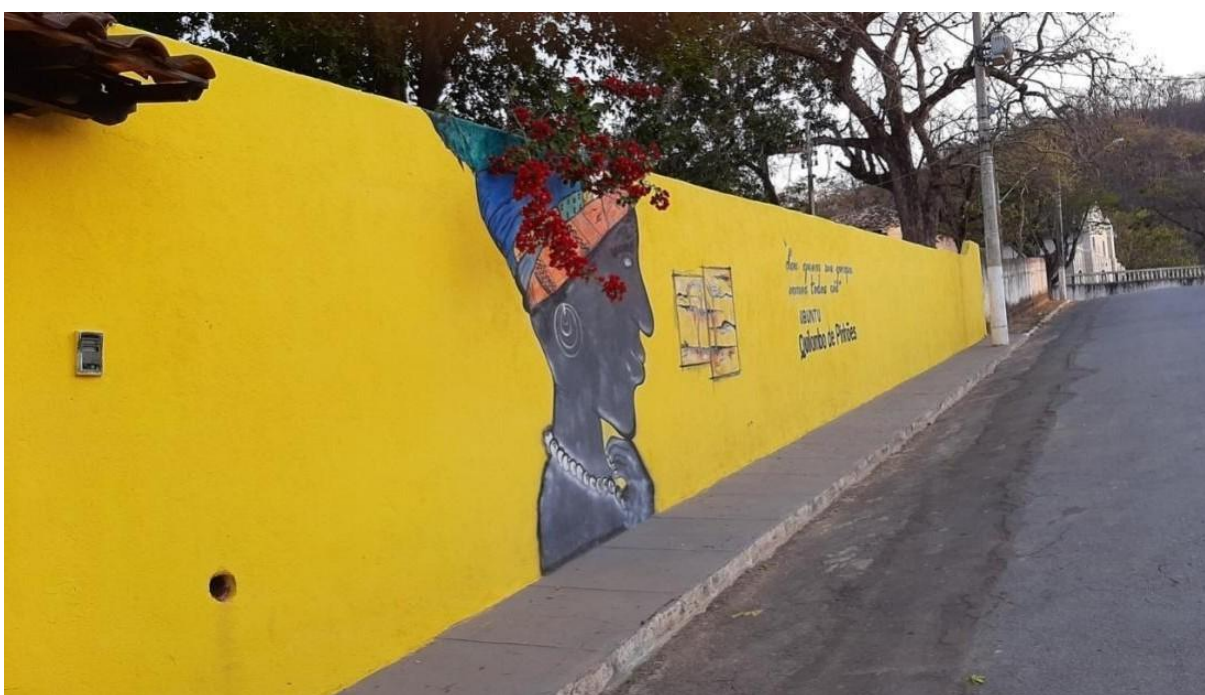
Figura 19 - Muro da Escola Estadual Padre João de Santo Antônio
