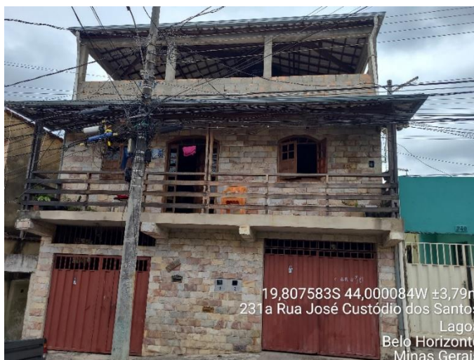
Figura 118: Edificação com varanda que avança sob a via Fonte: Foto 112325 capturada pelo autor
