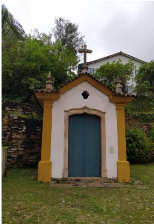
Foto 13: Passo da Ponte Seca
