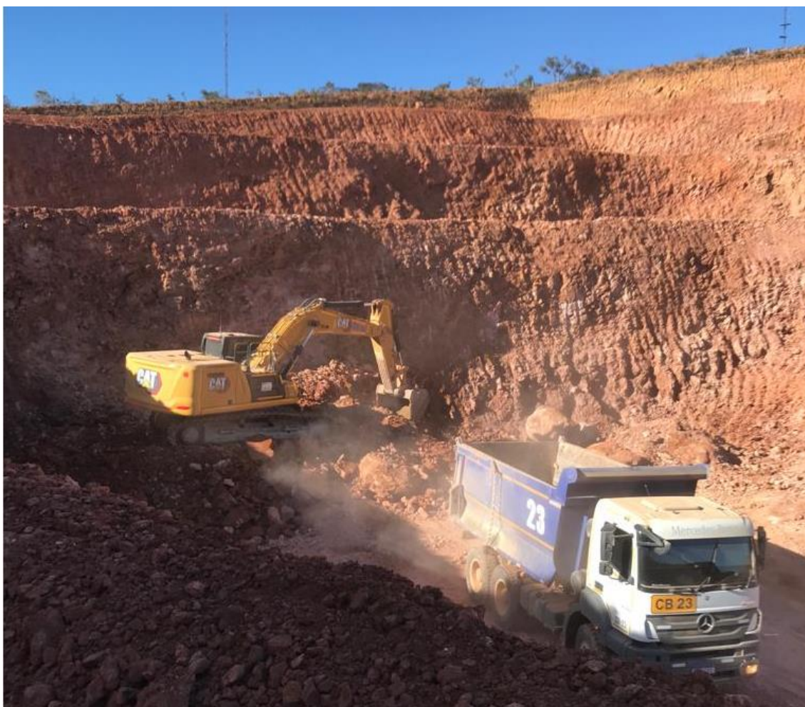
Figura 34 - Operações de lavra na mina de Barro Alto.
