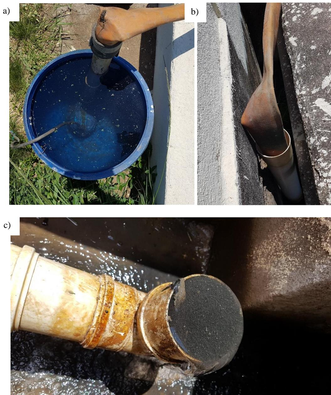
**Figura 0.4** – a) Barril de 500 L preenchido com água com uma bomba submersa. b) Mangote da bomba adaptada na tubulação de aeração passiva. c) Detalhes do efluente com desprendimento de sólidos logo após a lavagem das tubulações de drenagem.
