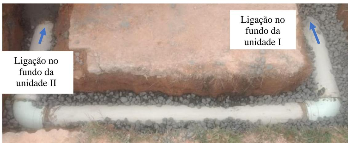
**Figura 0.2** - Detalhes da interligação do fundo (70 cm) das unidades I e II, durante a Etapa 2. Na foto, tubulação de 200 mm.
