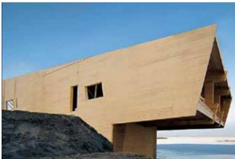
Figura 2.6 - Construção com Painel de CLT
