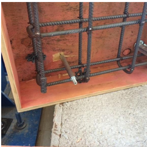
Figura 4.18 - Furos e fixação dos pinos
