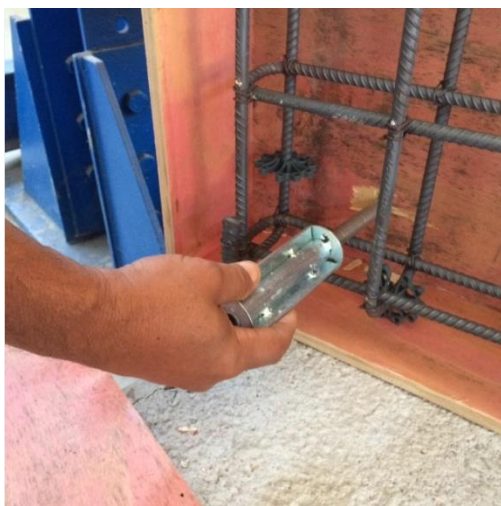
Figura 4.19 - Colocação da bucha nos pinos
