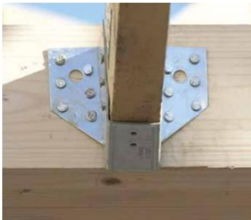
Figura 2.12 - Conector para viga
