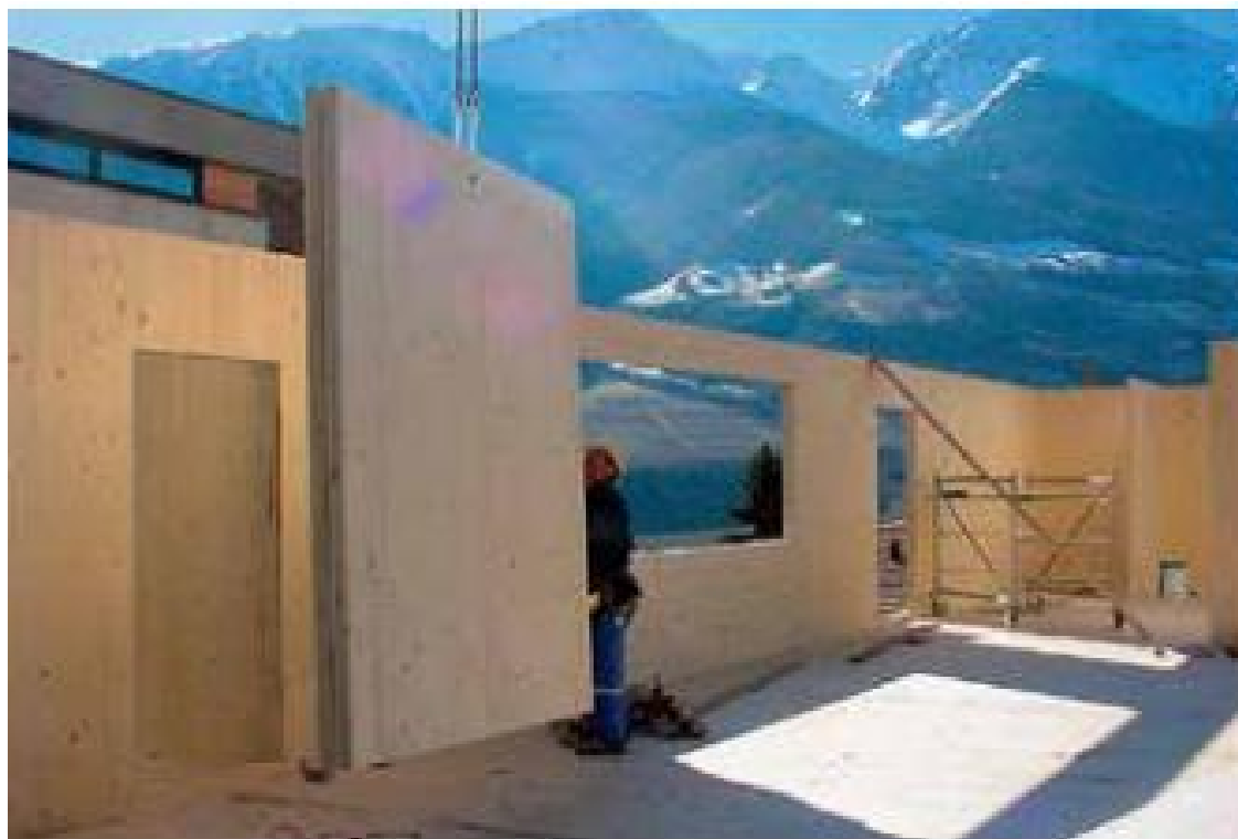
Figura 3.2 - Montagem de Painéis CLT - LENO
