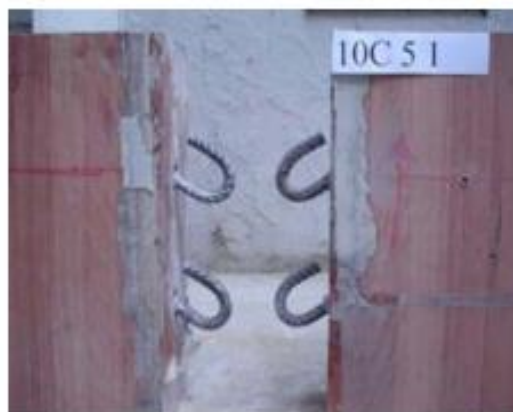
Figura 2.33 - Falha no conector e na madeira
