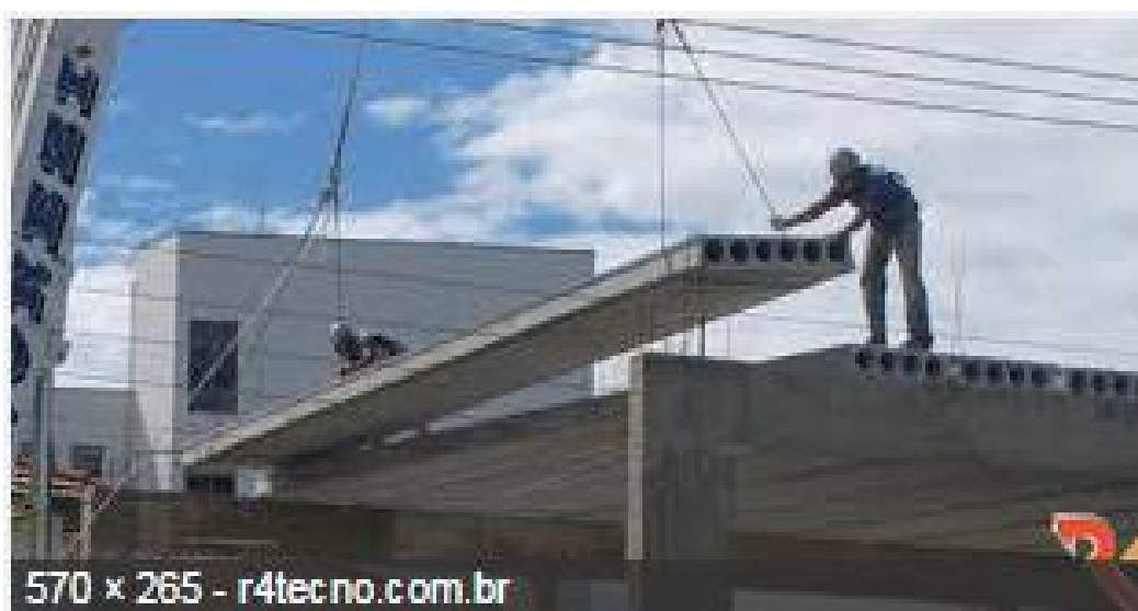
Figura 2.7 - Sistema pré-fabricado utilizando-se lajes alveolares de concreto
