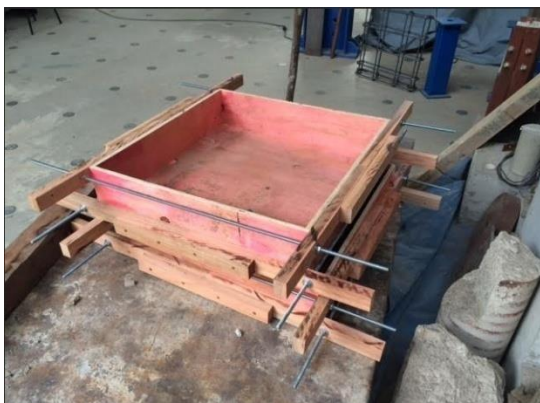
Figura 4.16 - Forma da laje de concreto
