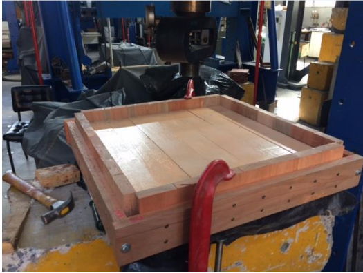
Figura 4.7 – Painel em fase de montagem
