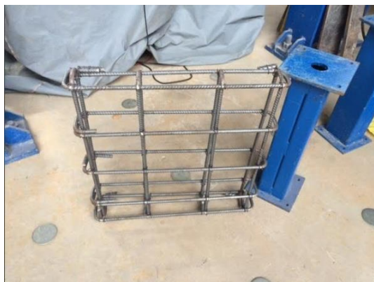
Figura 4.17 – A armação da laje
