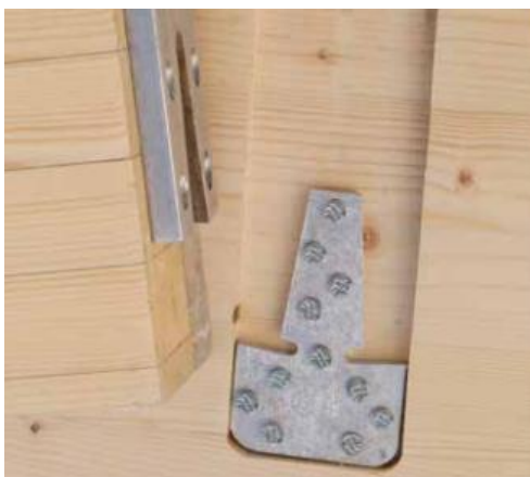
Figura 2.13 - Conector oculto para viga
