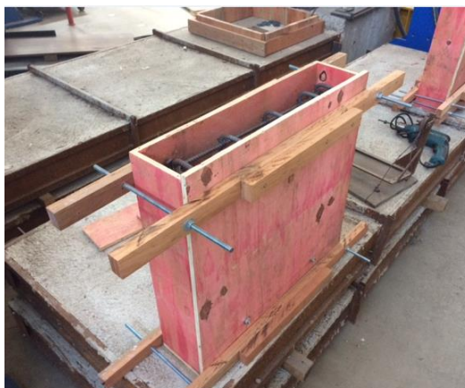
Figura 4.22 - Fôrma na posição de concretagem
