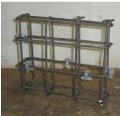
Figura 2.26 - Armação das lajes concreto
