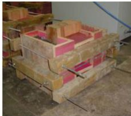
Figura 2.27 - Concretagem das lajes
