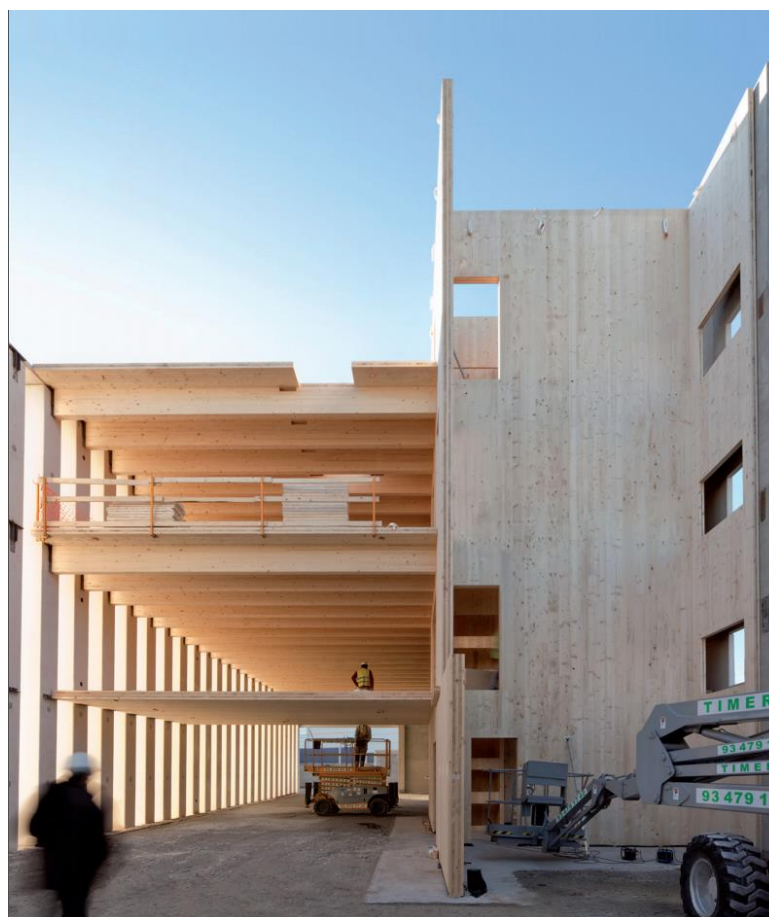
Figura 2.5 - Construção com Painel de CLT
