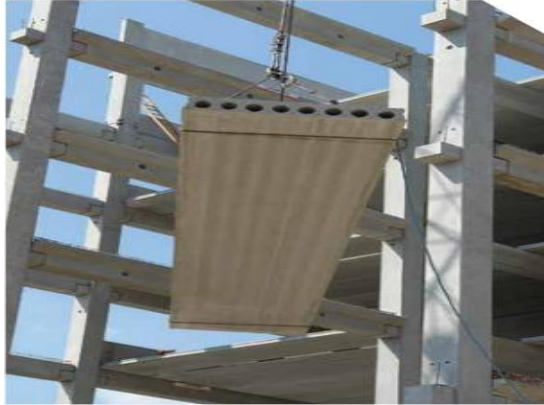
Figura 3.3 - Laje pré-fabricada alveolar, içada na obra
