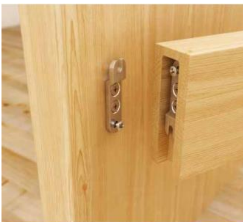
Figura 2.15 - Conector oculto para vigas
