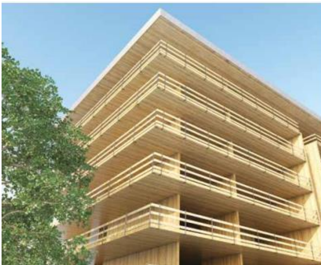
Figura 2.3 - Edifício construído com CLT
