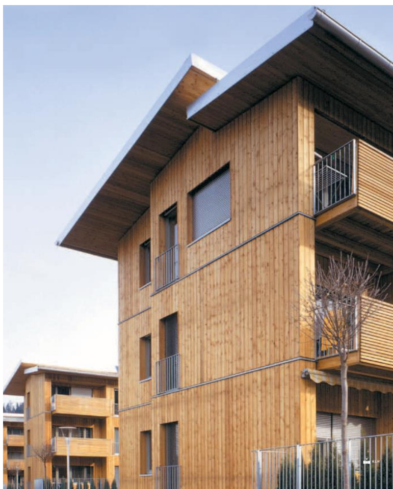
Figura 1.1 - Exemplo de Edificação Construída com CLT
