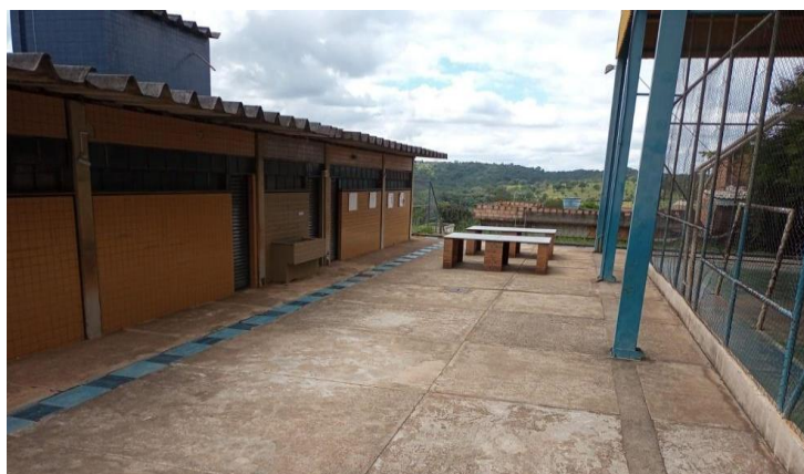
Figura 10 – Parte externa da quadra da EMMECB, em frente aos vestiários
