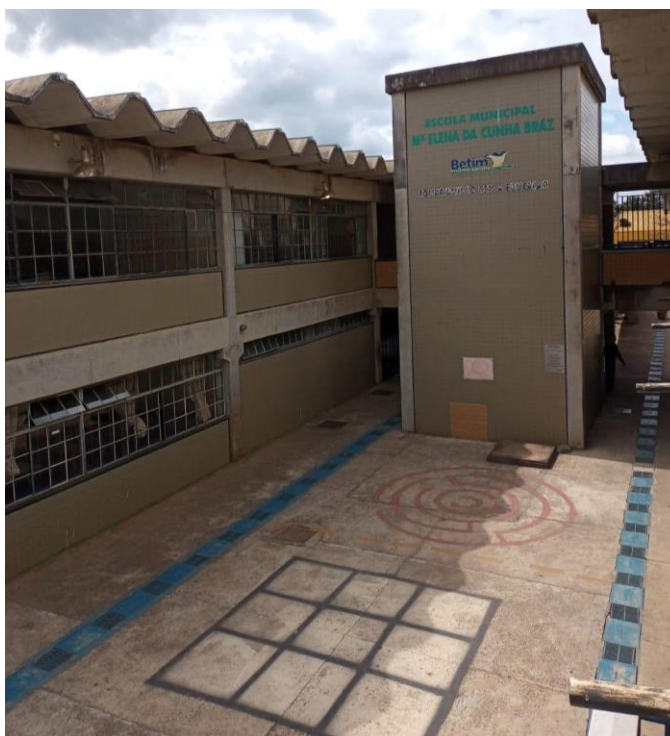
Figura 12 – O pátio em frente ao portão de entrada
