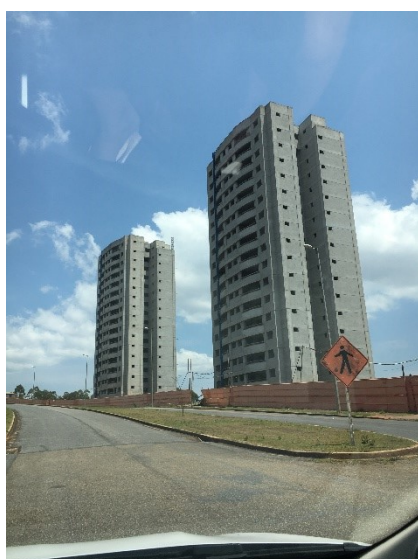
Edifícios em construção na Av. Wimbledon, obra da empresa RKM Lottus Engenharia
