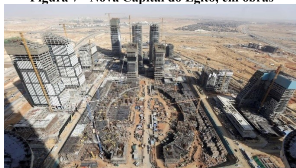
Figura 7 - Nova Capital do Egito, em obras
