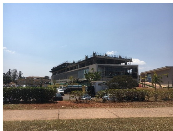
Shopping Navegantes, em obras para expansão
