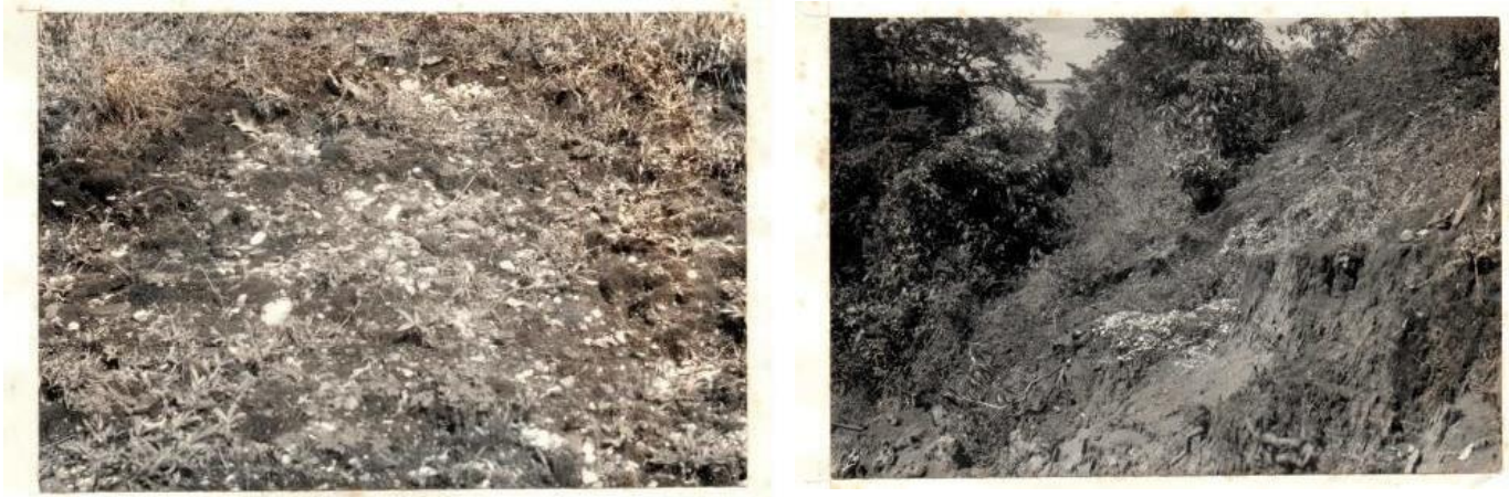
Figura 17 – Fotos do ambiente do sítio PA-AL-13 Boa Vista – Detalhes do processo erosivo decorrente do desmatamento e uma camada cedendo formando degraus e impactando a estratigrafia arqueológica.
