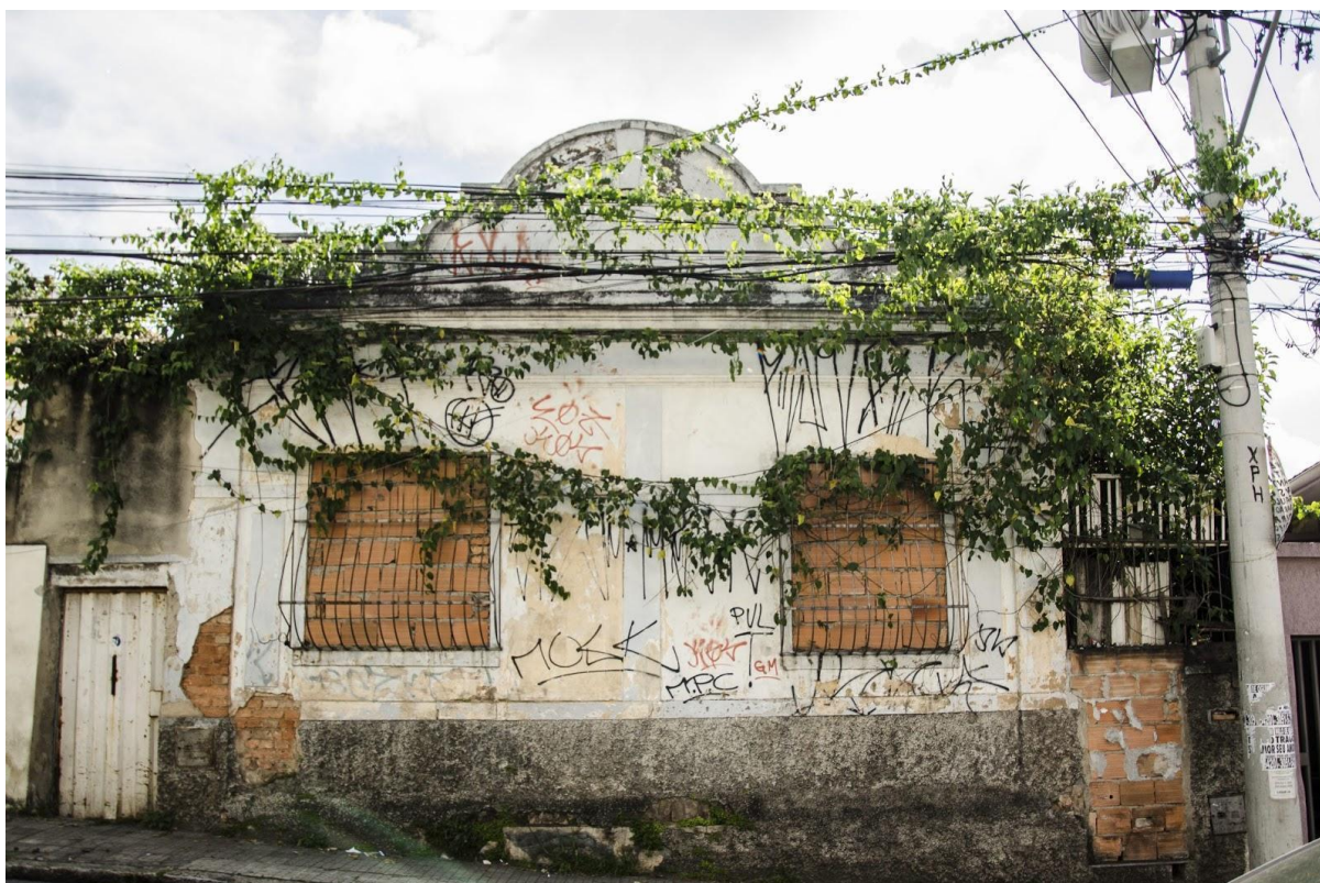
FIGURA 8 - Fachada de edificação tombada na Lagoinha
