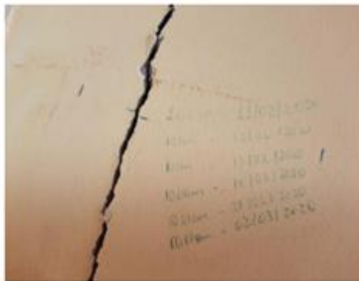
Figura 8 - Registros da deformação. Fonte: Acervo fotográfico da escola, 2021.
