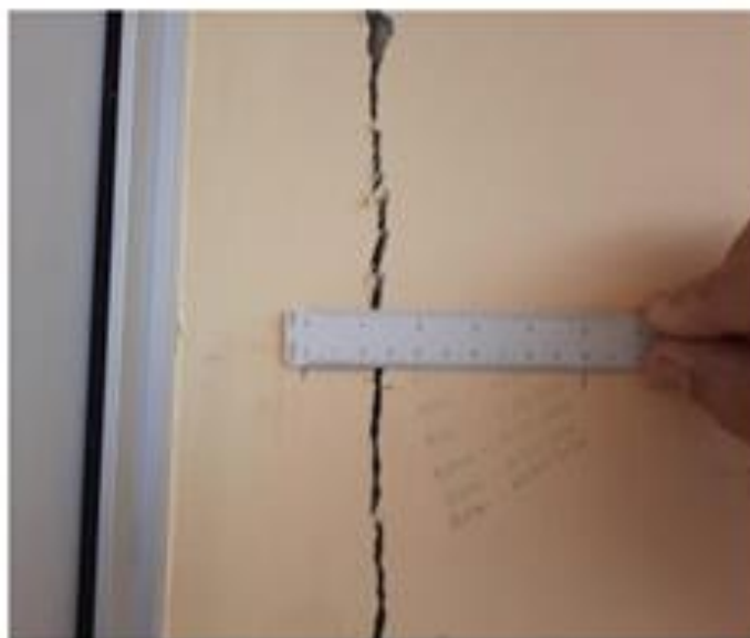
Figura 9 - Medição atual da deformação. Fonte: Acervo fotográfico da escola, 2021.
