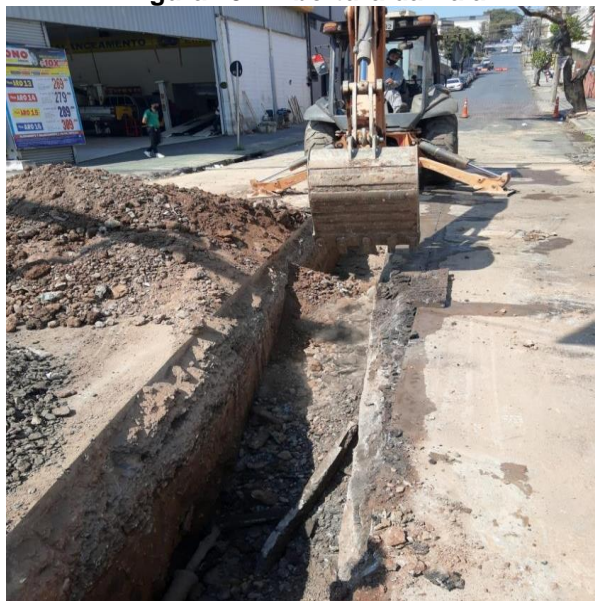
Figura 29 – Abertura da Vala
