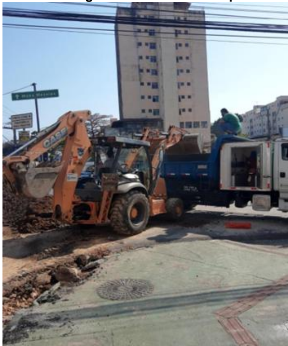
Figura 33 – Carregamento no caminhão para bota-fora
