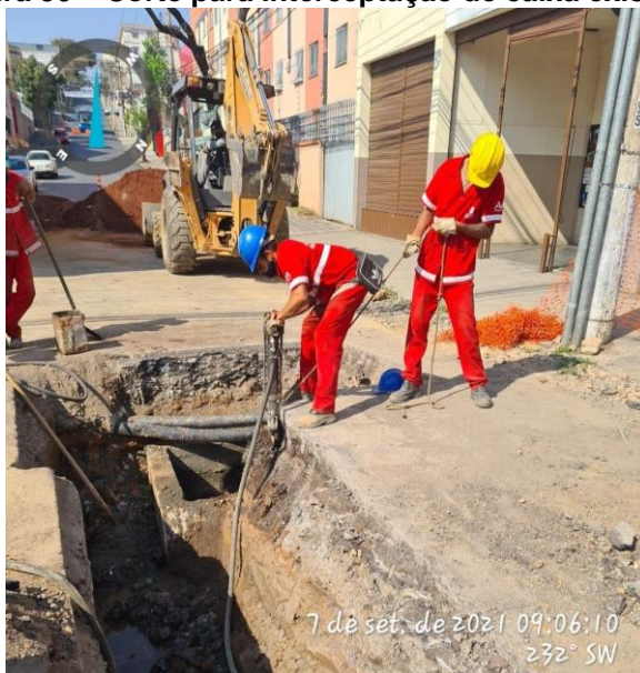
Figura 30 – Corte para interceptação de caixa existente
