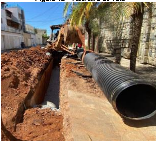
Figura 12 – Abertura de vala
