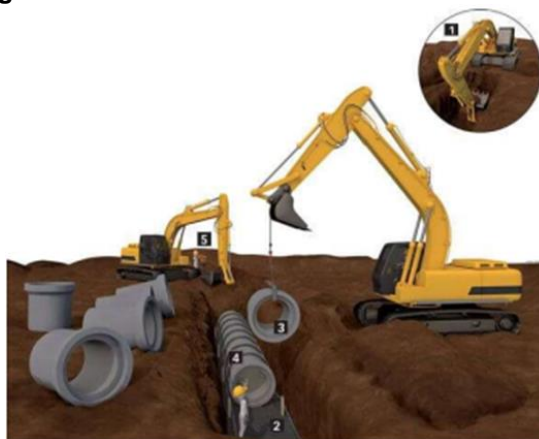
Figura 11 – Assentamento de tubos de concreto
