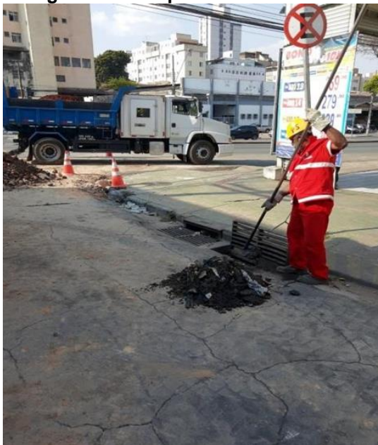
Figura 28 – Limpeza da boca de lobo
