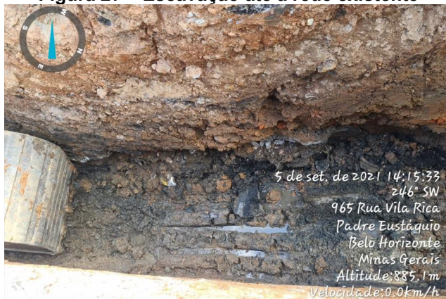
Figura 27 – Escavação até a rede existente
