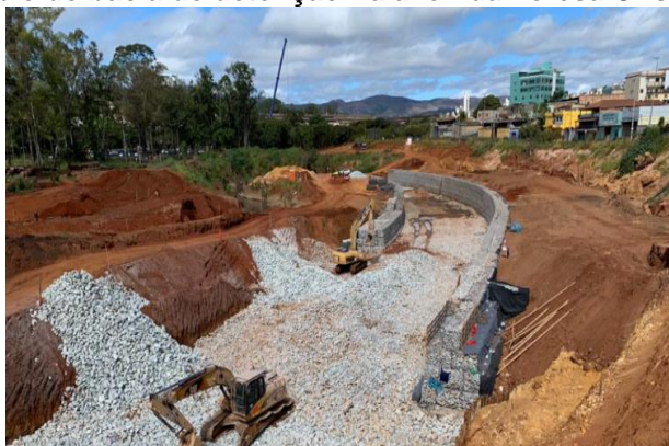
Figura 13 – Exemplo de bacia de retenção na avenida Teresa Cristina, em BH
