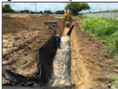
Figura 22 – Execução da trincheira
