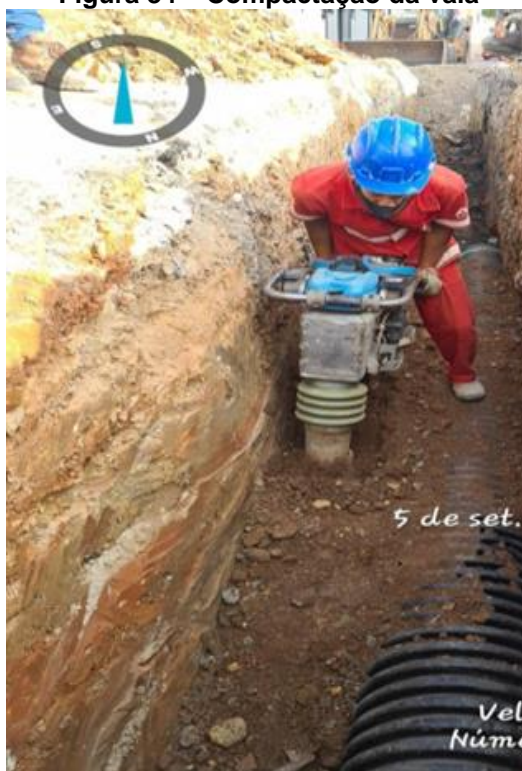
Figura 34 – Compactação da vala
