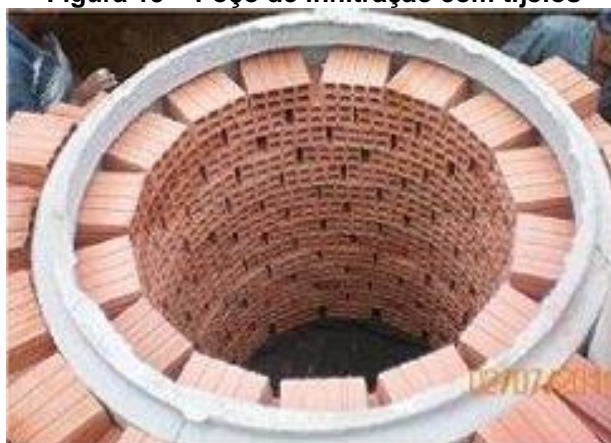
Figura 19 – Poço de infiltração com tijolos
