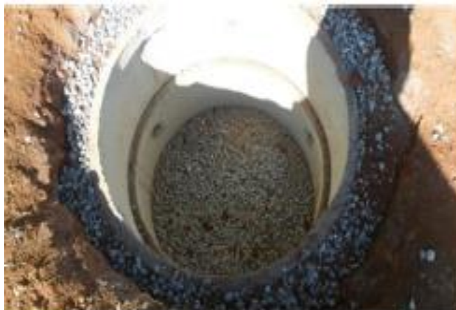
Figura 20 – Poço de infiltração com concreto furado
