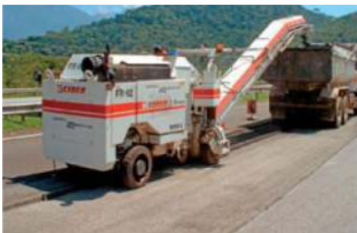
Figura 13: Processo de fresagem
