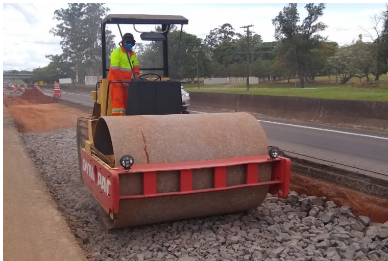
Figura 27: Compactação da camada de rachão (antes).
