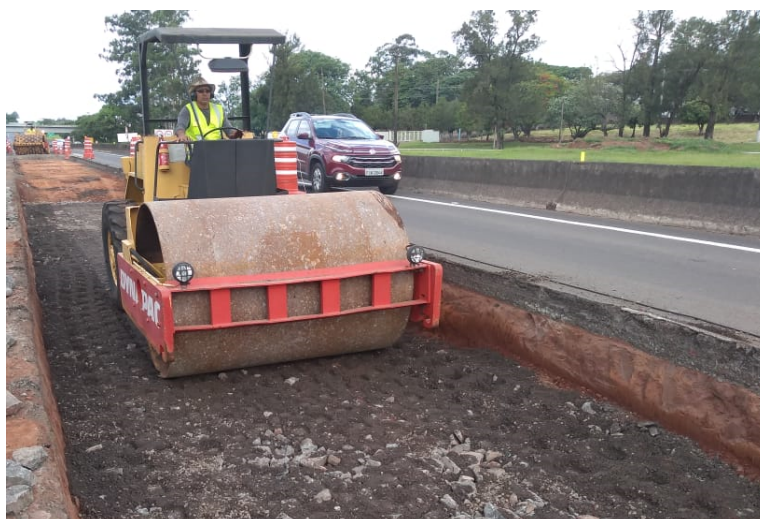
Figura 28: Compactação da bica corrida com rolo liso (durante).
