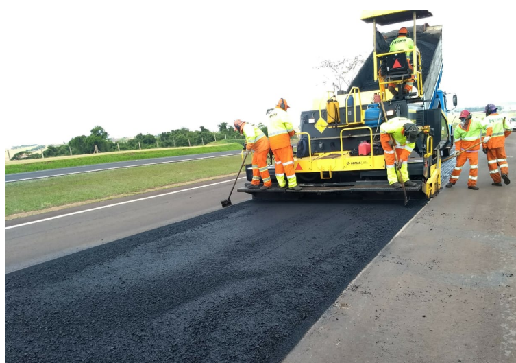
Figura 20: Aplicação da massa asfáltica (durante).
