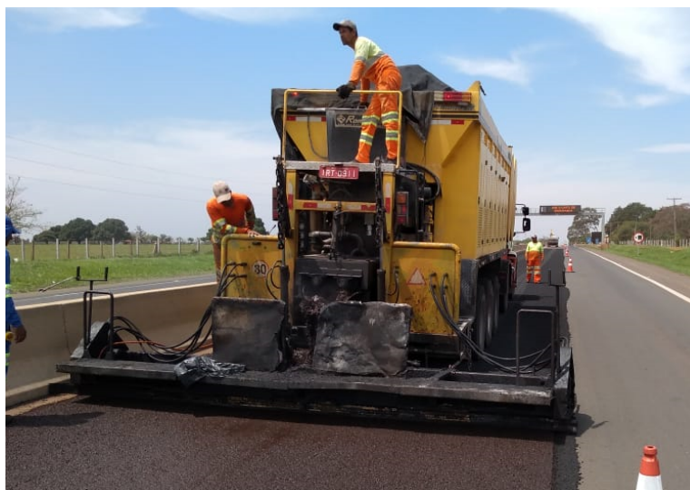
Figura 23: Aplicação da segunda Camada (Durante)
