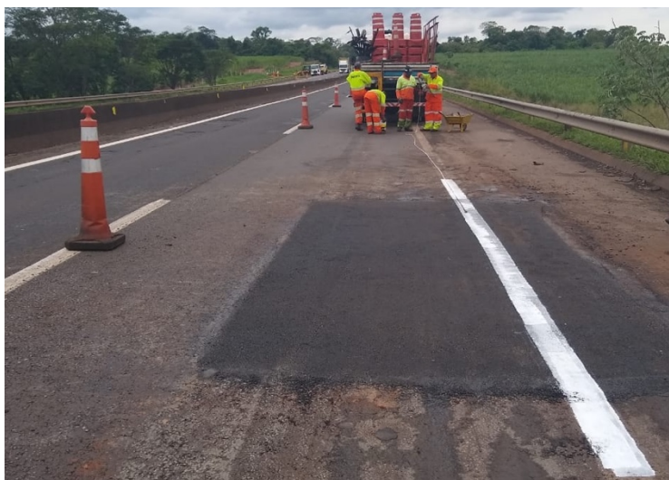
Figura 17: Trecho com execução do remendo finalizado (Depois).
