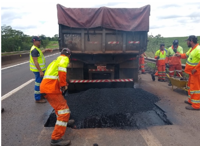
Figura 16: Trecho fresado com pintura de ligação e aplicação do concreto betuminoso usinado à quente (durante).
