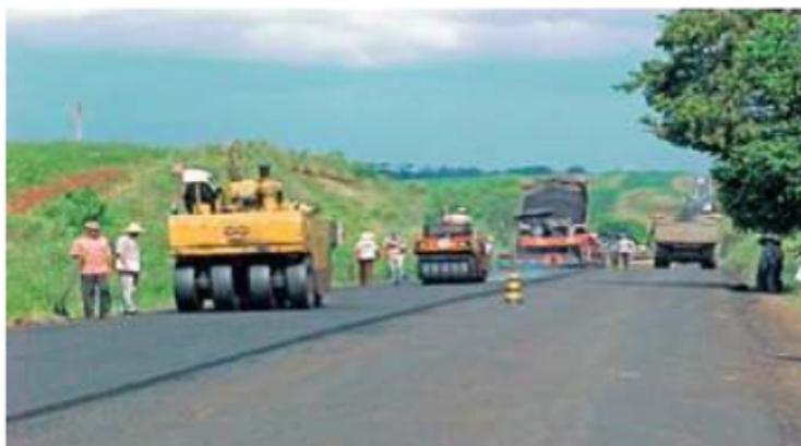
Figura 12: Processo de recapeamento.
