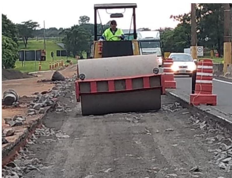
Figura 30: Compactação de BGS com rolo liso vibratório (durante).
