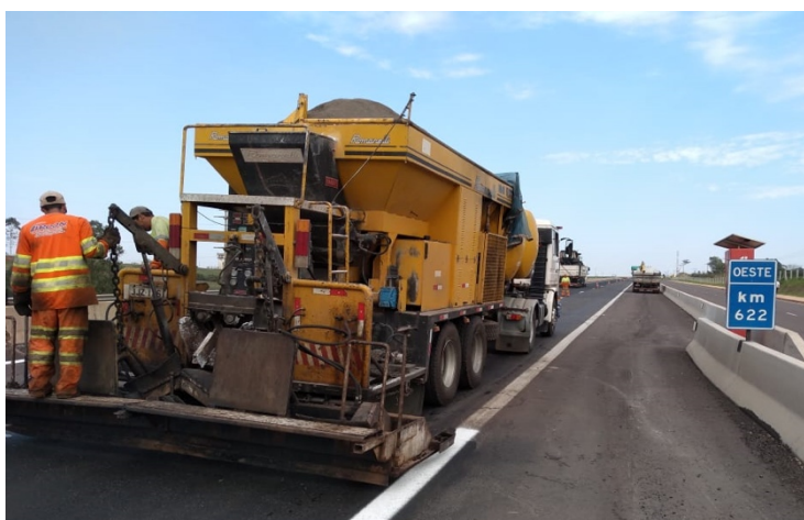
Figura 22: Aplicação do Microrrevestimento asfáltico com multidistribuidora
