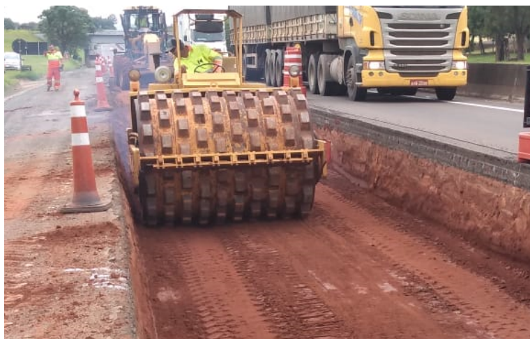
Figura 26: Compactação do fundo da caixa (durante).
