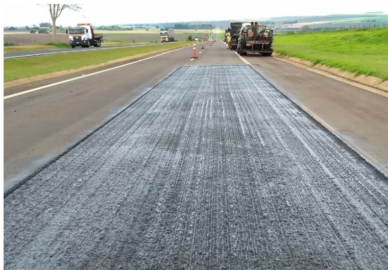
Figura 19: Trecho fresado com aplicação de emulsão asfáltica (durante).
