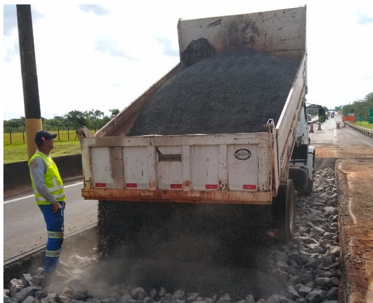
Figura 29: Espalhamento da Brita Graduada Simples com caminhão basculante (durante).
