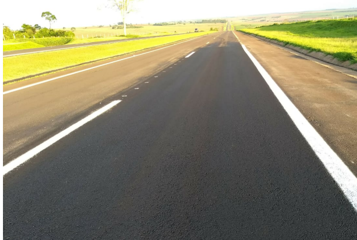
Figura 21: Trecho com fresagem e recomposição finalizada (depois).
