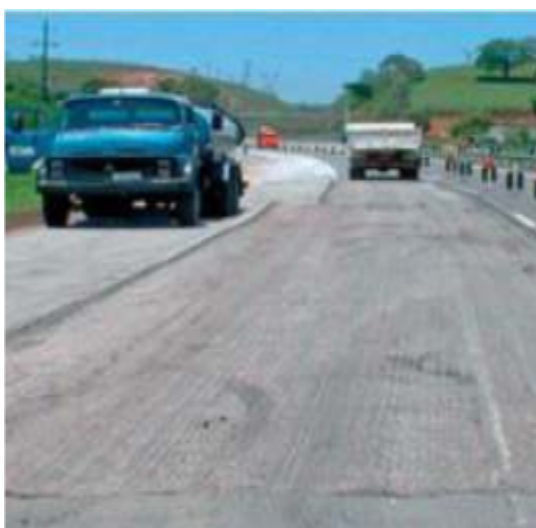
Figura 14: Pista após fresagem
