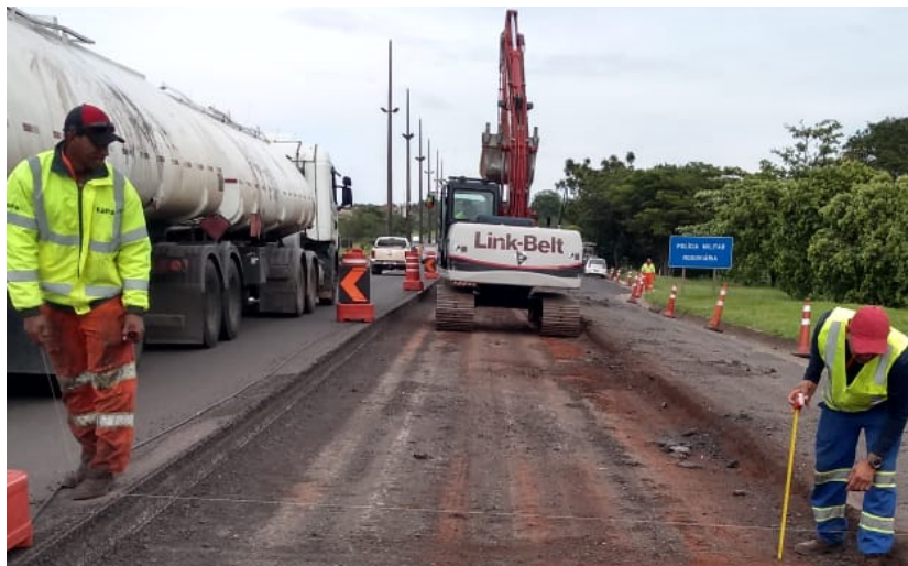
Figura 25: Fresagem (durante).
