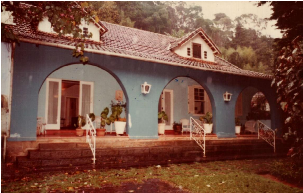
Rua Mosela 289, Petrópolis – a Casa Azul (Fonte: CAALL)
