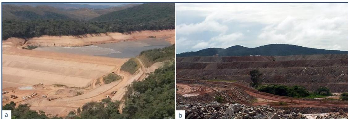
Figura 2.1 – a) Foto de uma barragem de rejeitos e b) Foto de uma pilha de estéril<sup>25</sup>
