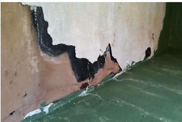
Figura 4 - Parede subsolo após impermeabilização
