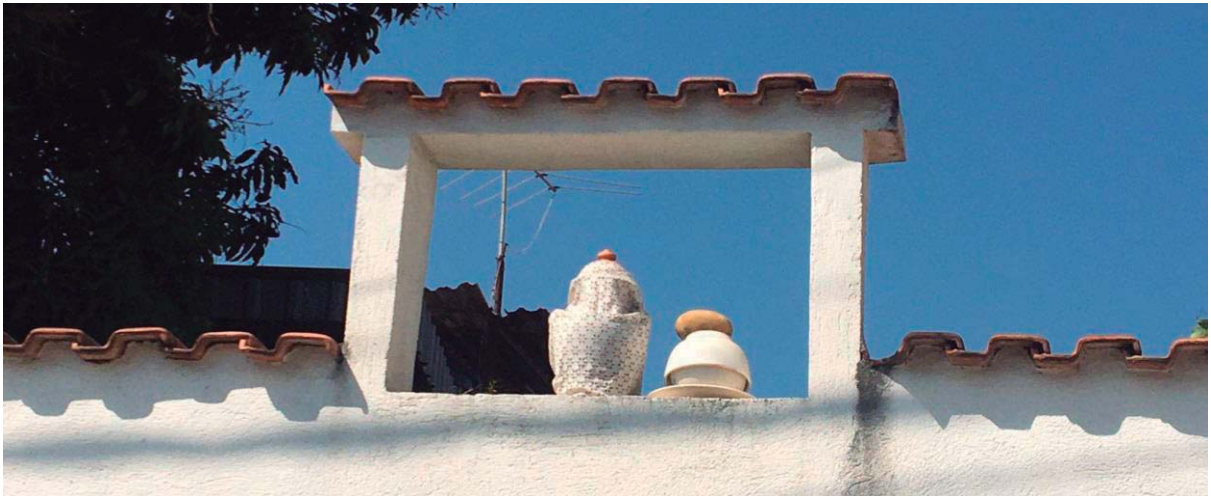
Figura 4 – Detalhe de um porrão no alto de um muro de divisa de uma casa de Candomblé no bairro
