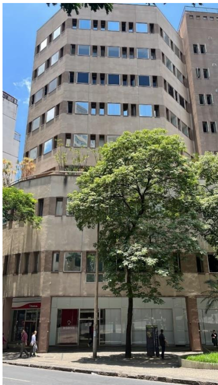
Figura 39 – Sede regional do Banco Bradesco, Belo Horizonte
