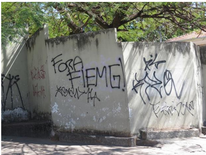
Figura 42 – Muro do Mercado Distrital Santa Tereza, 5 de setembro de 2014
