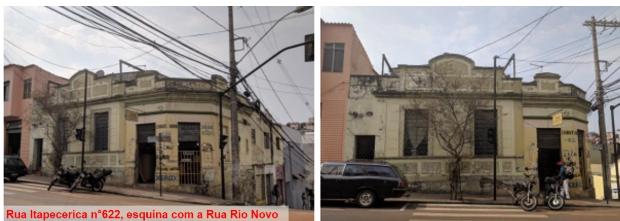
Figura 63 - Imóvel situado na Rua Itapecerica, 622
