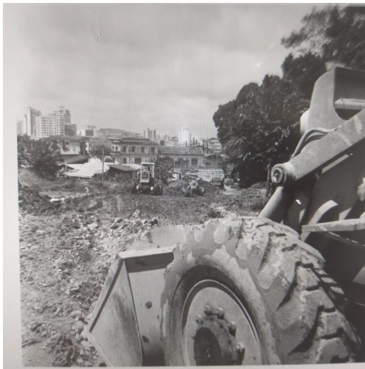
Figura 36- Obras no Viaduto Carlos Prates
