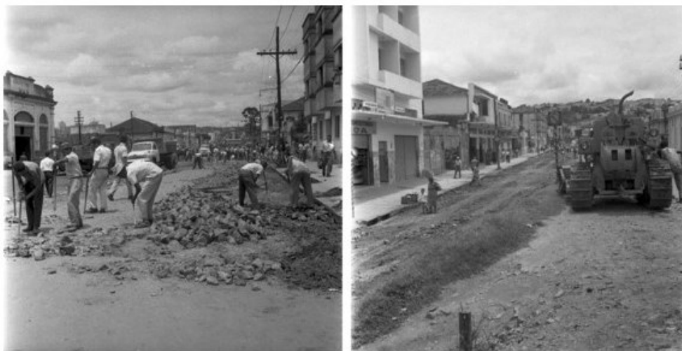
Figura 26 - Remoção dos trilhos na Praça Vaz de Melo e Rua do Ramal
