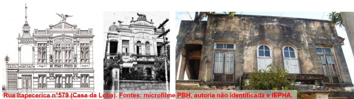
Figura 64 - Imóvel situado na Rua Itapecerica, 579
