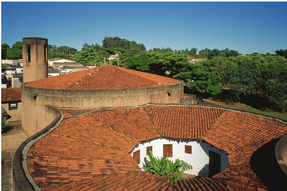
Figura 16: Igreja do Espírito Santo do Cerrado. Lina Bo Bardi, 1975-1982. Uberlândia, Minas Gerais. Jardim interno.
