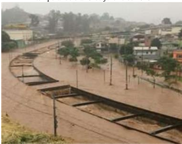
FIGURA 2. Alagamento da Av. Tereza Cristina, próximo ao bairro Betânia e Cidade Industrial após temporal do dia 19 de janeiro de 2020
