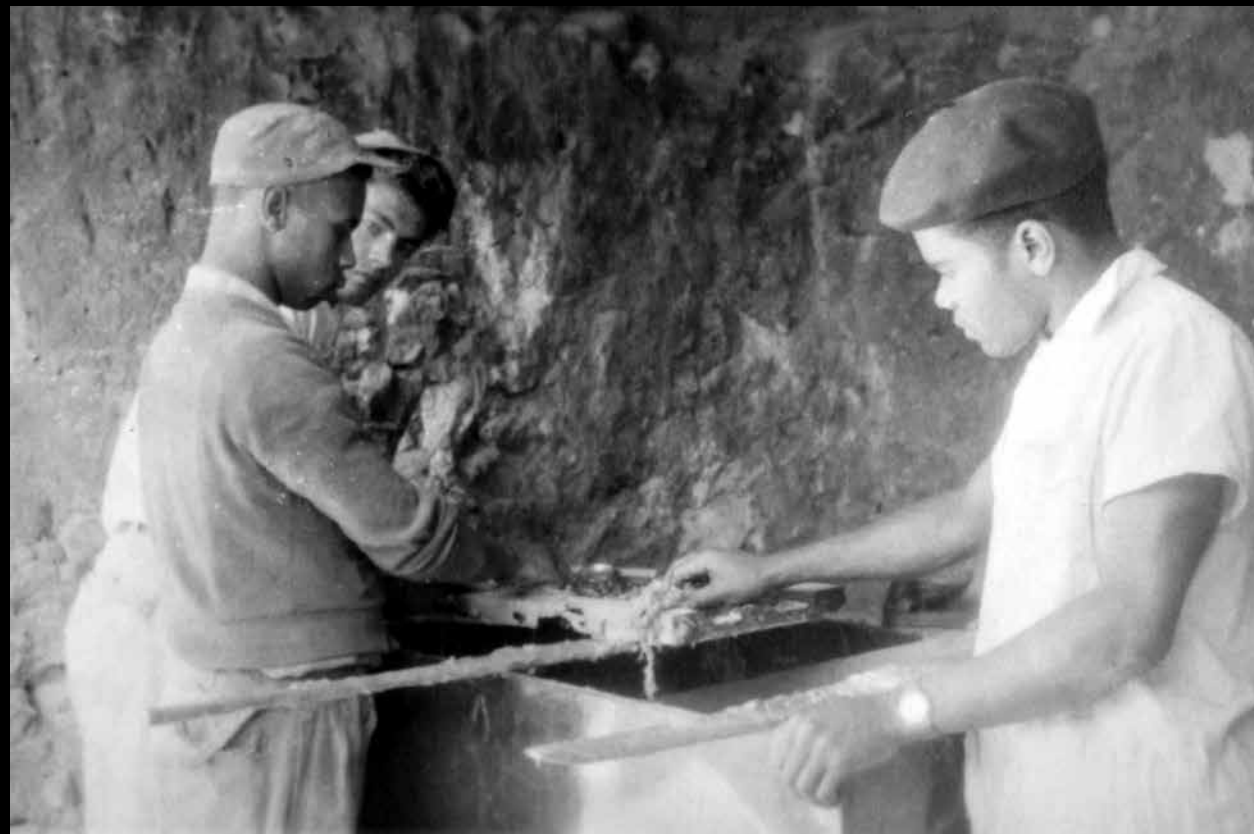
Fig. 66 – Jair Inácio (primeiro à direita) no comando das obras de restauração e intervenção na capela-mor da Matriz de Nossa Senhora do Pilar de São João del-Rei Fonte: Arquivo Eclesiástico da Paróquia Nossa Senhora do Pilar de São João del-Rei (AEPNSP-SJRD)
