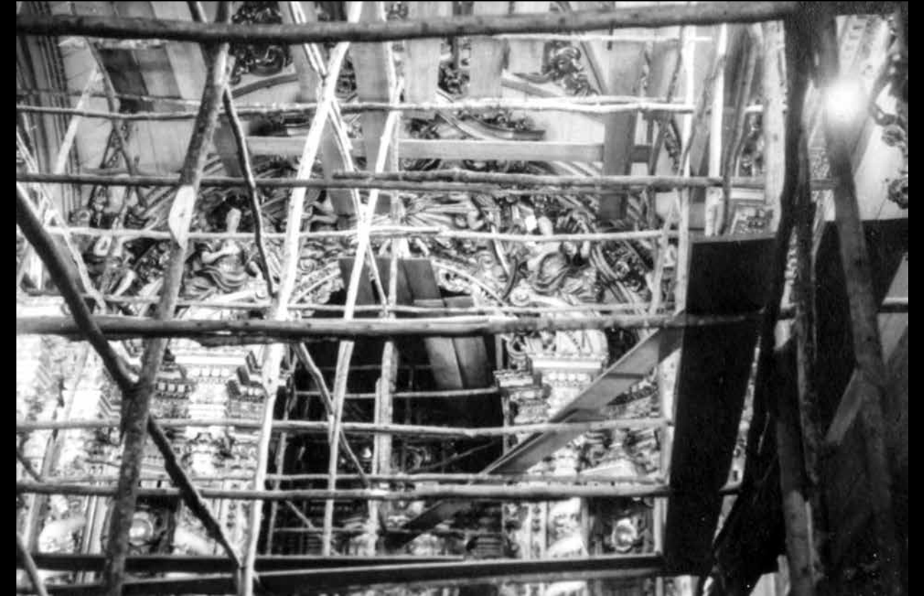
Fig. 64 – Foto dos andaimes montados pela equipe técnica do SPHAN, na capela-mor da Matriz de Nossa Senhora do Pilar, para iniciar a Campanha de Restauração total da igreja entre os anos de 1955 e 1958. Com os trabalhos de restauração liderados pelo respeitado mestre Jair Inácio, decano dos restauradores ouropretanos e supervisionada pelo competente arquiteto e professor Sylvio de Vasconcellos, começava a se fazer uma das obras mais complexas de intervenção no patrimônio cultural mineiro, cujo principal objetivo, dentro da mentalidade da época era resgatar os elementos artísticos originais da Igreja setecentista Fonte: Arquivo Eclesiástico da Paróquia Nossa Senhora do Pilar de São João del-Rei (AEPNSP-SJRD)
