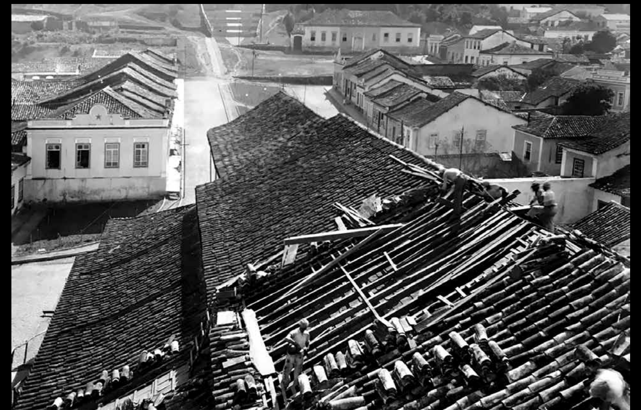
Fig. 65 – Foto do início da intervenção na cobertura da nave da Matriz de Nossa Senhora do Pilar. Vê-se parcialmente à esquerda, a escada e os andaimes montados pela equipe técnica do SPHAN, para iniciar a Campanha de Restauração total da igreja, realizada entre os anos de 1955 e 1958 Fonte: Arquivo Eclesiástico da Paróquia Nossa Senhora do Pilar de São João del-Rei (AEPNSP-SJRD)
