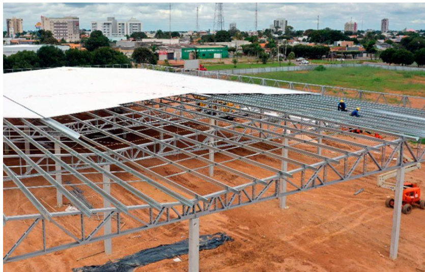
Figura 1 – Cobertura Metálica de uma Rodoviária em Sinop (MT)
