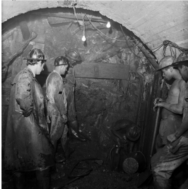
Figura 37: Perfuração do Túnel Taquaril. Abril de 1969.
