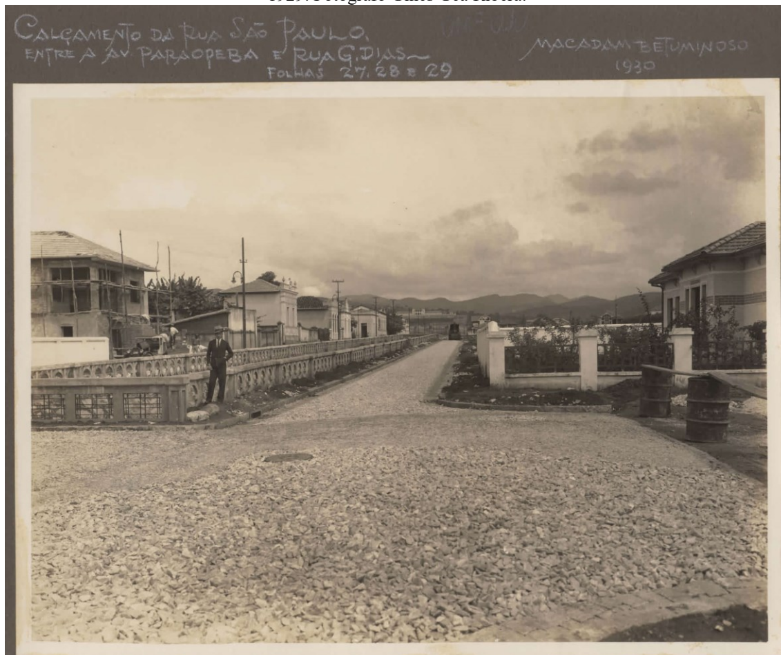
Figura 7: Calçamento da rua São Paulo esquina com rua Gonçalves Dias em Belo Horizonte. Data: 1926-1929. Fotografia Gines Gea Ribera.
