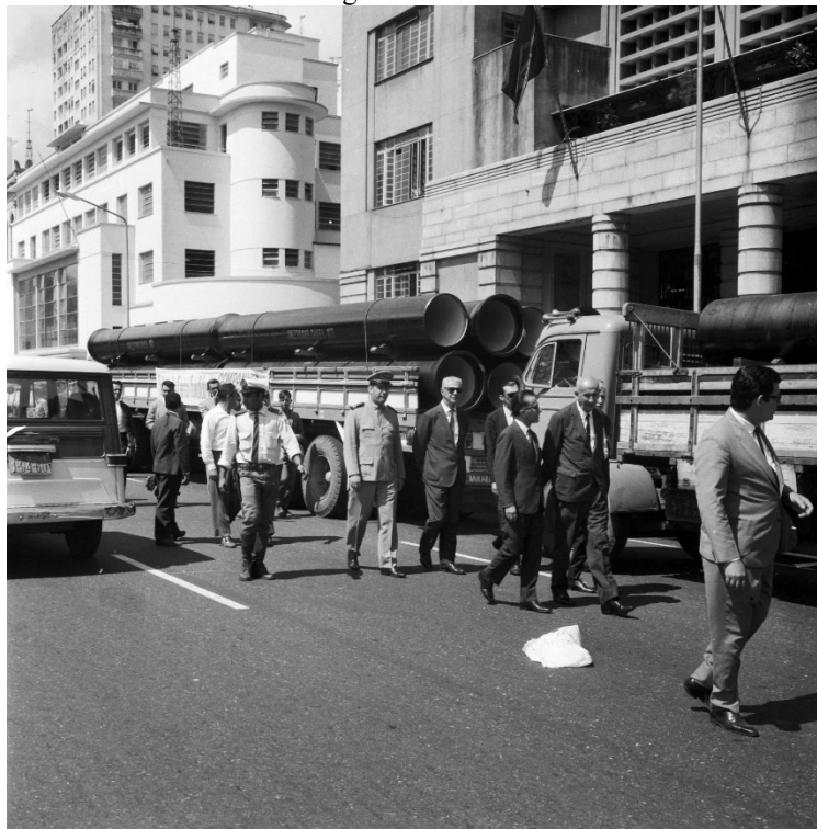
Figura 35: Tubulações de água e esgotos recém adquiridas pelo DEMAÉ expostas na porta da prefeitura. Agosto de 1968.
