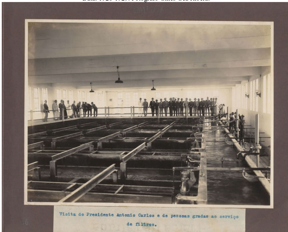
Figura 10: Visita do presidente Antônio Carlos à nova estação de tratamento de água de Belo Horizonte. Data: 1926-1929. Fotógrafo Gines Gea Ribera.
