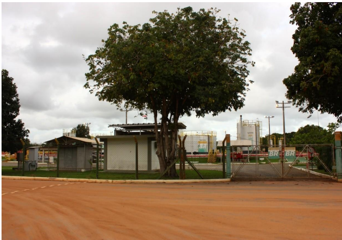
Figura 6: Unidade de Processamento de Gás Natural de Lagoa Parda.
