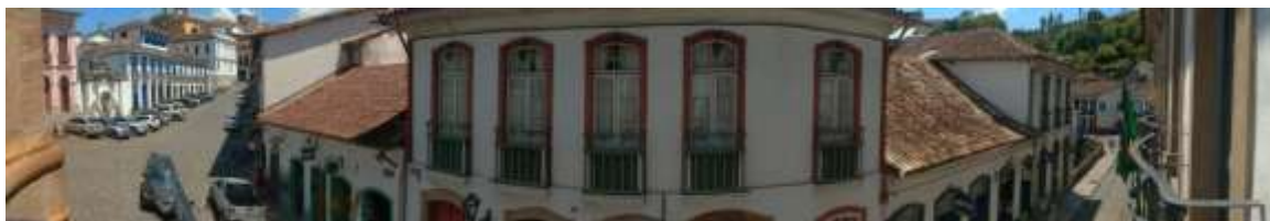
Figura 94 – Vista panorâmica do segundo andar do Museu Casa dos Contos
