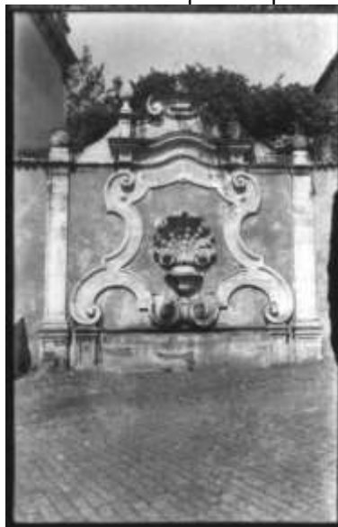
Figura 85 – Chafariz dos Contos restaurado pela Inspetoria de Monumentos Nacionais
