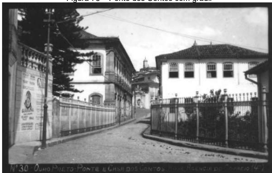
Figura 75 – Ponte dos Contos com gradil
