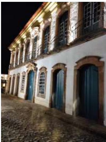
Figura 90 – Fachada do Museu Casa dos Contos
