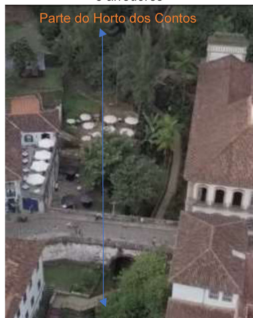
Figura 122 – Vista aérea da Ponte dos Contos e arredores
