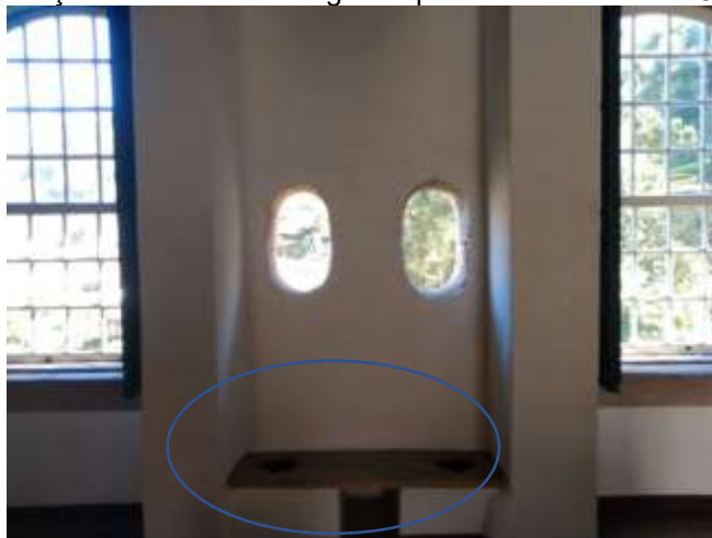
Figura 81 – Instalações sanitárias no segundo pavimento do Museu Casa dos Contos
