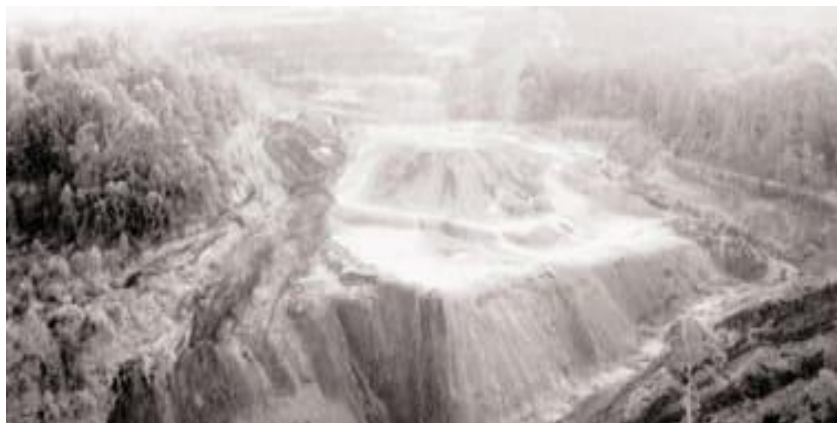
Figura 2: Barragem da Mineração Rio Verde.
