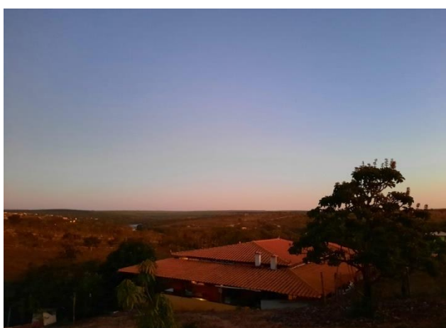
Figura 71: Casa totalmente construída, em 2013.
