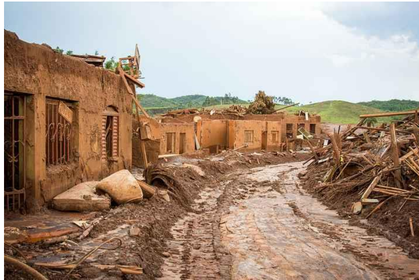
Figura 7: Rua de Bento Rodrigues, em Mariana, após o rompimento da barragem do Fundão, em 2015. Autor: PONTES, Romerito. 2015
