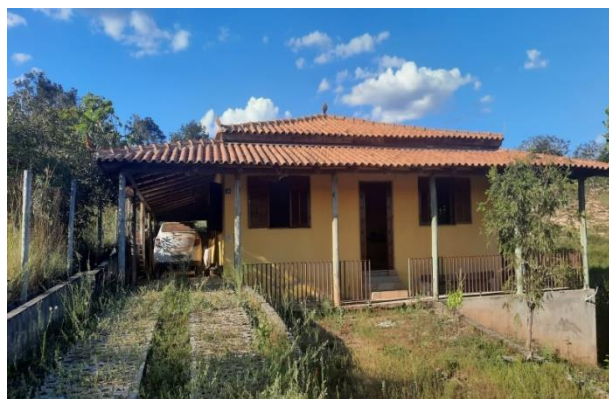
Figura 94: Mato invadindo a entrada da casa do meu pai, em 2022.
