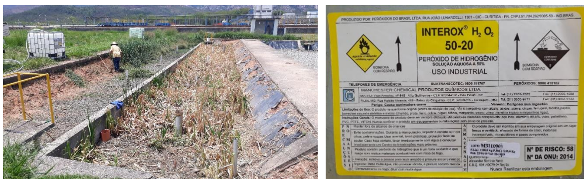
Figura 5-16: Tanque IBC de peróxido de hidrogênio posicionado ao lado do sistema (esquerda) e ficha de segurança com informações importantes colada no tanque IBC (direita).
