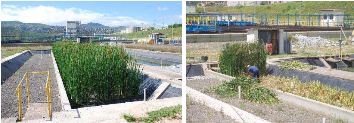
Figura 4-3: Vegetação desenvolvida e primeiro corte da parte aérea. Fonte: Dornelas (2008).
