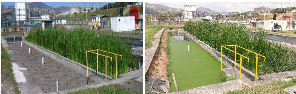
Figura 5-4: Wetlands de escoamento horizontal subsuperficial, unidade plantada e não plantada, no início do período operacional (esquerda) e após 12 anos de operação (direita). Nota-se a proliferação de lemnáceas sobre a lâmina d'água da unidade não plantada.
