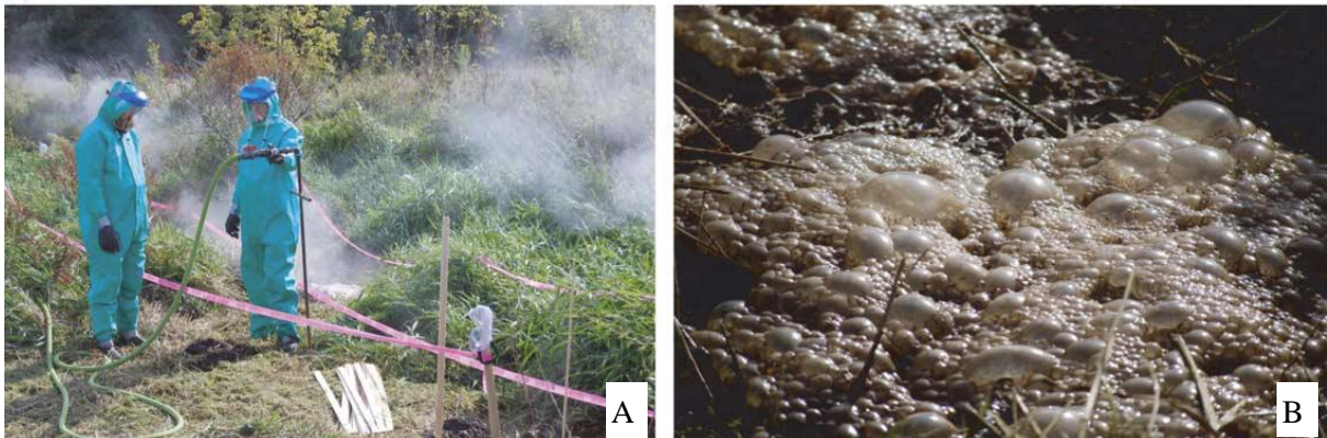
Figura 3-9: Aplicação de peróxido de hidrogênio em wetlands horizontais. A) Utilização do tree jetter para injeção do peróxido de hidrogênio no leito e utilização de equipamento de proteção individual. Observe a produção de vapor no momento de aplicação; B) detalhe da superfície do leito durante a reação, gerando bolhas em função da reação de oxidação. Fonte: Nivala e Rousseau (2009).
