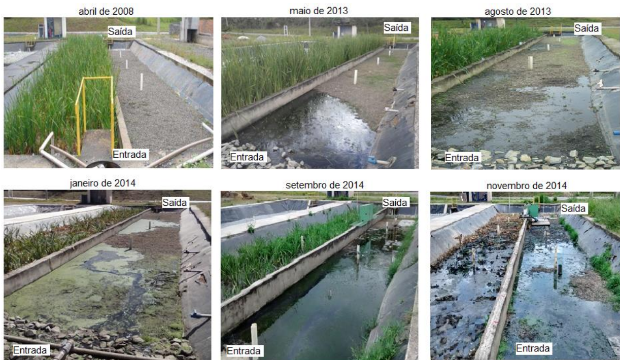
Figura 4-14: Evolução do escoamento superficial nas unidades plantada e não plantada ao longo do tempo. Fonte: Vasconcellos (2015).
