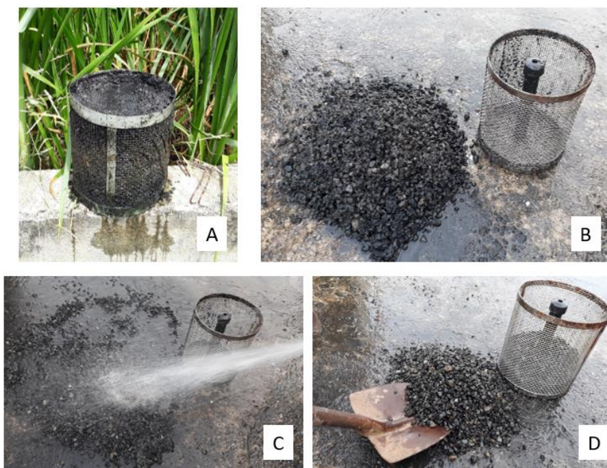
Figura 5-13: Procedimento de lavagem do material suporte. A) retirada da cesta do leito; B) retirada do material suporte da cesta; C) jateamento de água; D) devolução do material já limpo para a cesta.
