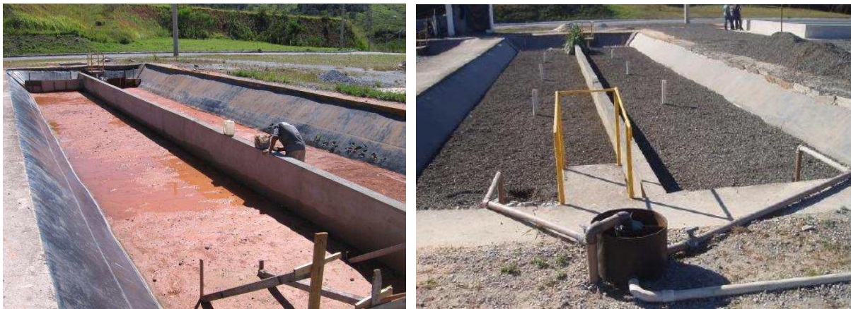
Figura 4-1: Wetlands horizontais em etapa de construção. Fonte: Dornelas (2008).
