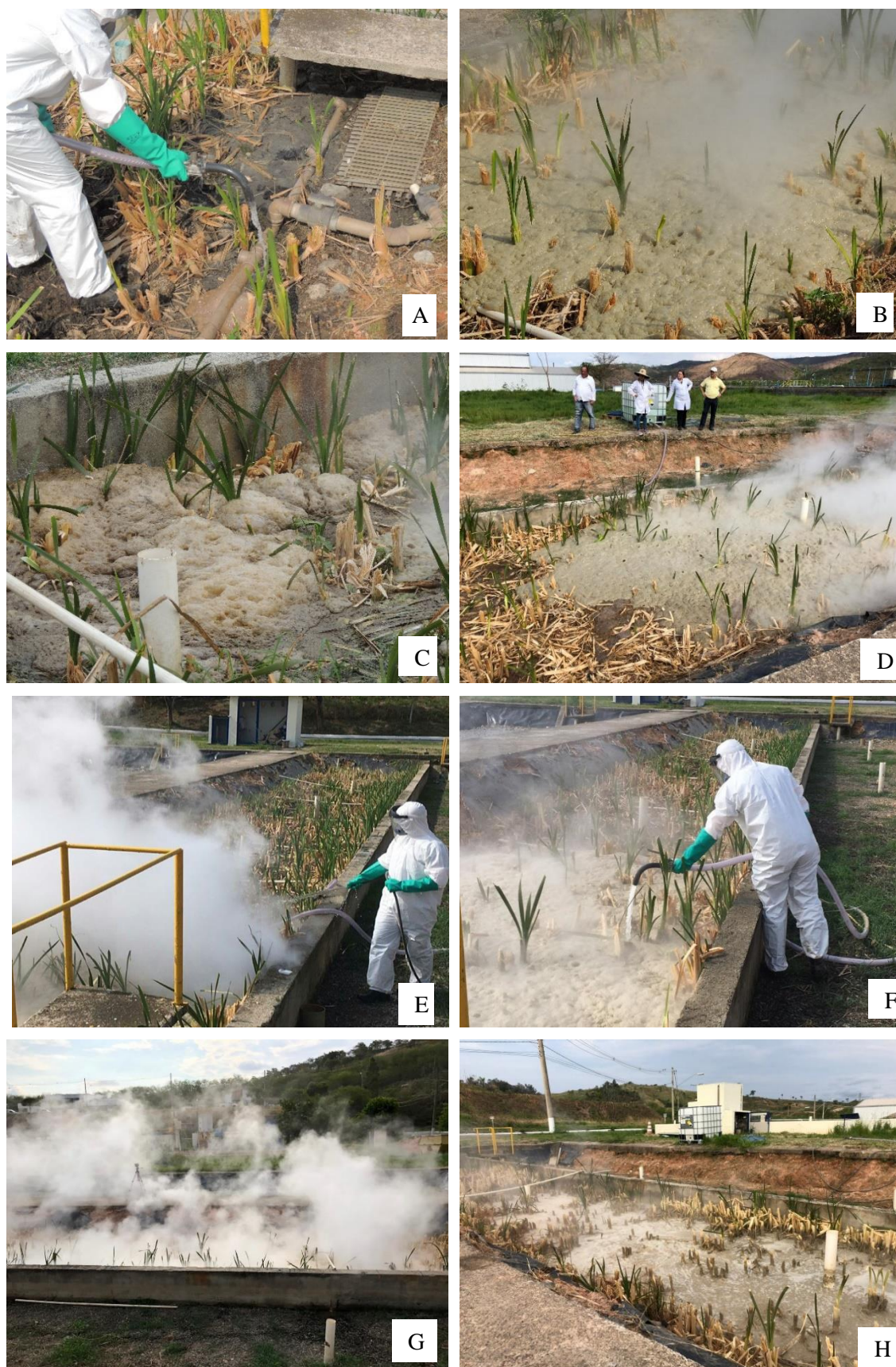
Figura 6-35: Aplicação de peróxido de hidrogênio na unidade plantada realizado no dia 12/11/2019. Fotos de A a H mostram o peróxido de hidrogênio sendo aplicado, a roupa de proteção utilizada e a formação de bolhas e fumaça no leito.
