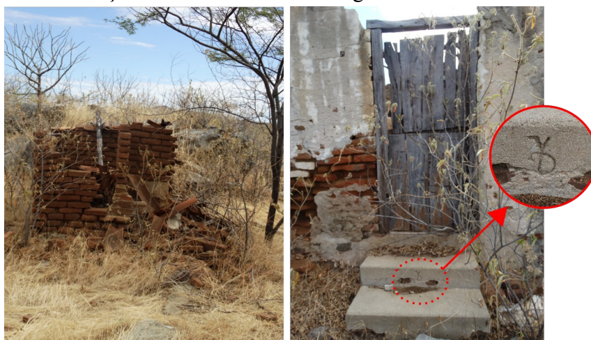
Figura 46 - Edificação arruinada e uma marca gravada na lateral sudoeste da casa
