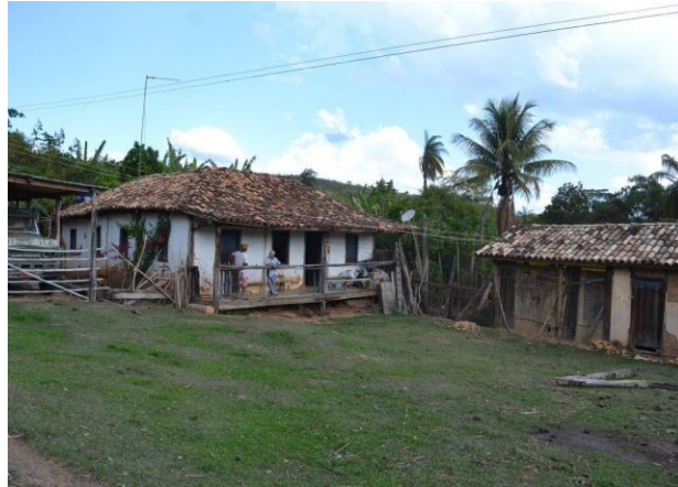
Figura 59 - Casa tradicional de terra na Varginha
