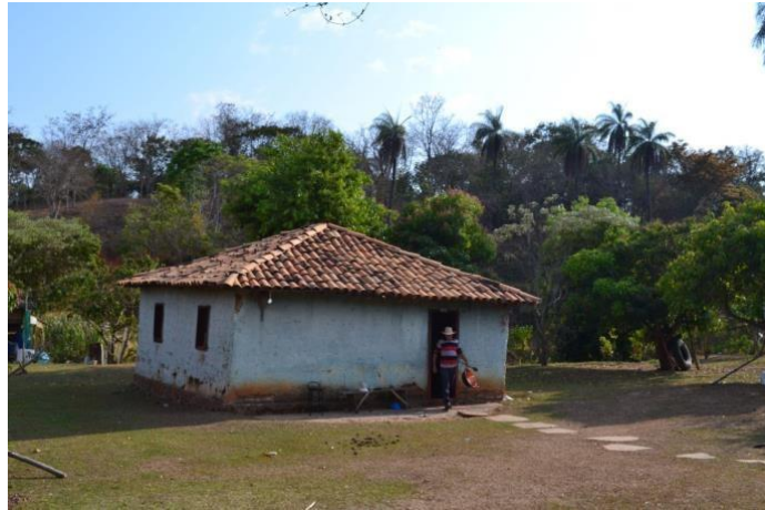
Figura 51 - Casa de terra adobe do Alfredo e Dalva em Mato Grande de Baixo
