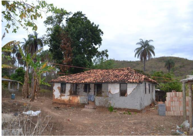
Figura 55 - Casa em Ribeiro Comprido - substituição do reboco de barro por de cimento
