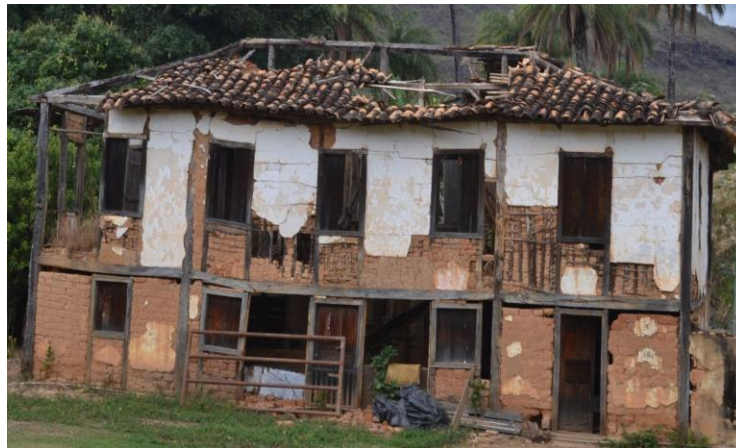
Figura 57 - Sobrado de dois pavimentos no Mato Grande Cima - Técnicas de adobe e pau a pique
