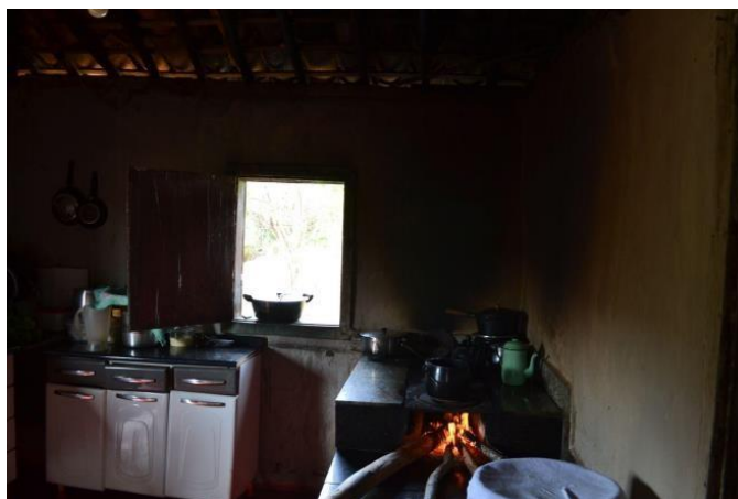
Figura 64 - Fogão a lenha de pedra e parede barreada com barro branco casa do Alfredo - Mato Grande de Baixo
