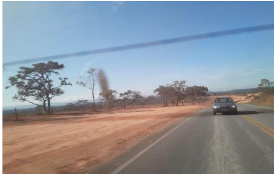
Figura 82 – Descampado nas proximidades do km 56 da Rodovia MG-10
