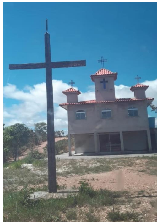
Figura 20 – Igreja de São Sebastião
