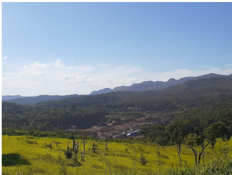
Foto: Barragem Córrego do Feijão. Data: 29/10/2021.
