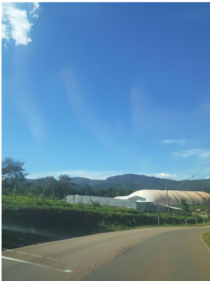
Foto: Construção do memorial vítimas do Rompimento da Barragem Córrego do Feijão. Data: 29/10/2021.
