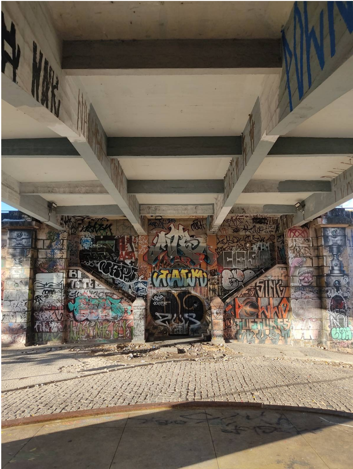
Figura 12 – Viaduto 8 - As escadas. Fonte: fotografia própria.
