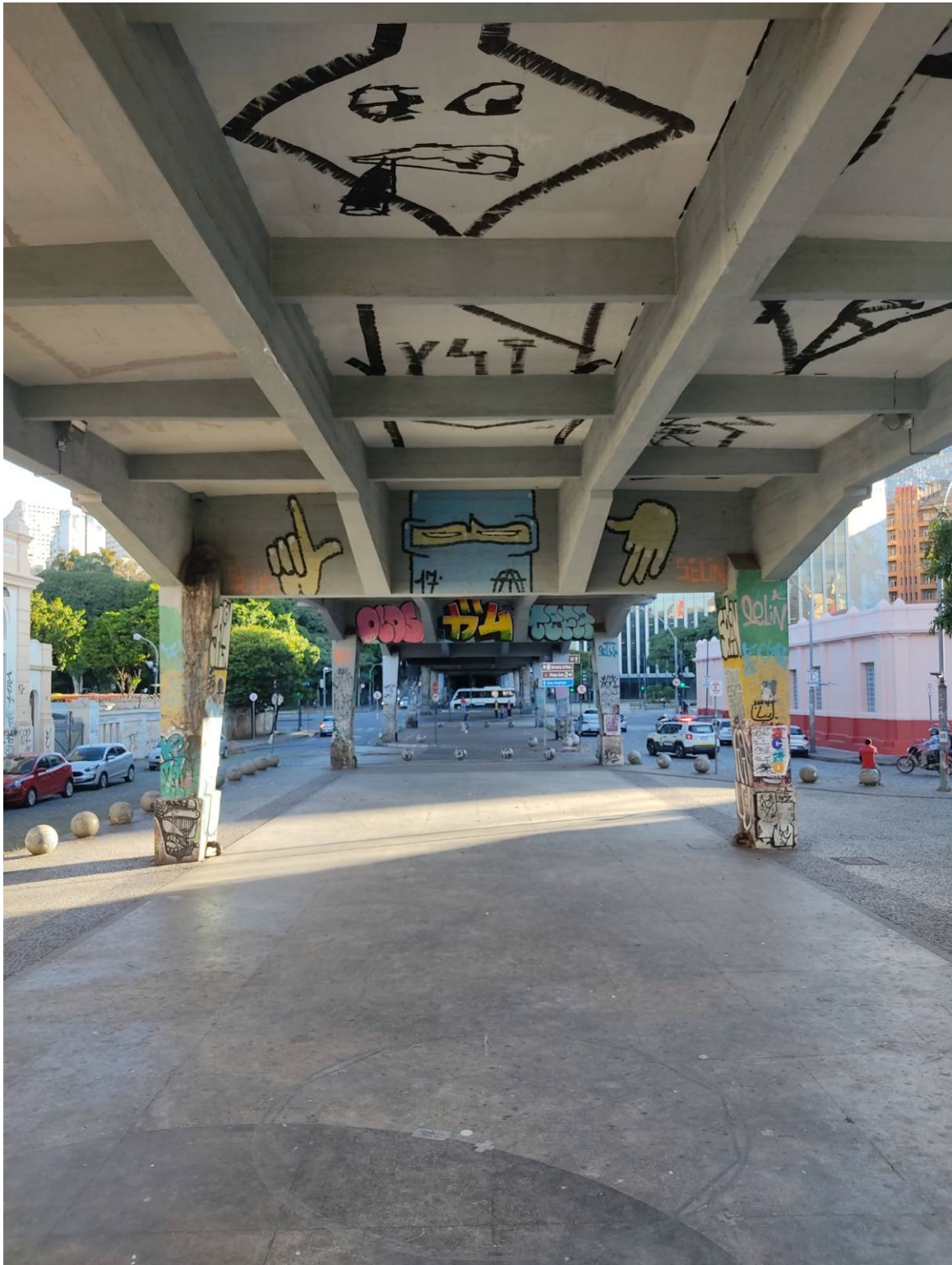
Figura 13 – Viaduto 9 - A liberdade segue sendo a nossa meta. Fonte: fotografia própria.
