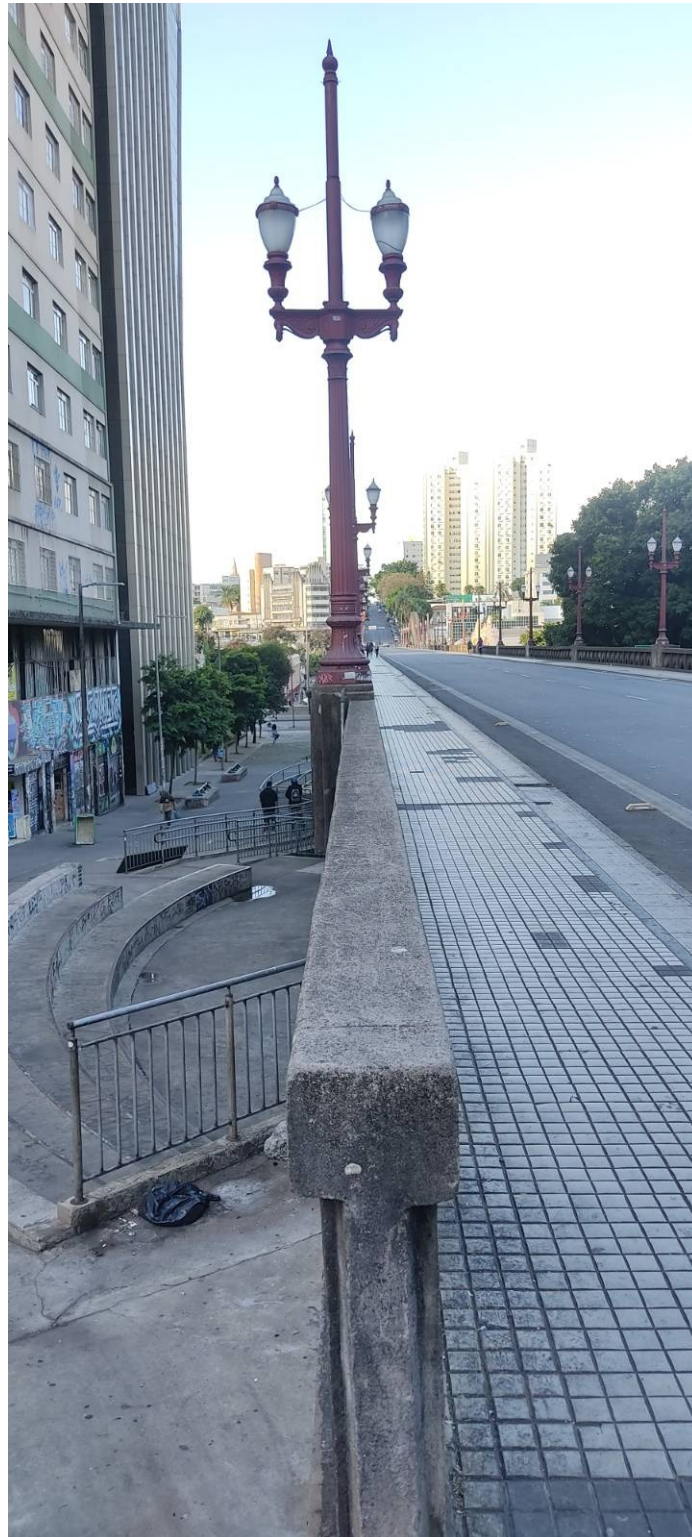
Figura 1 – Viaduto 1 - Dois Viadutos Santa Tereza Fonte: fotografia própria.
