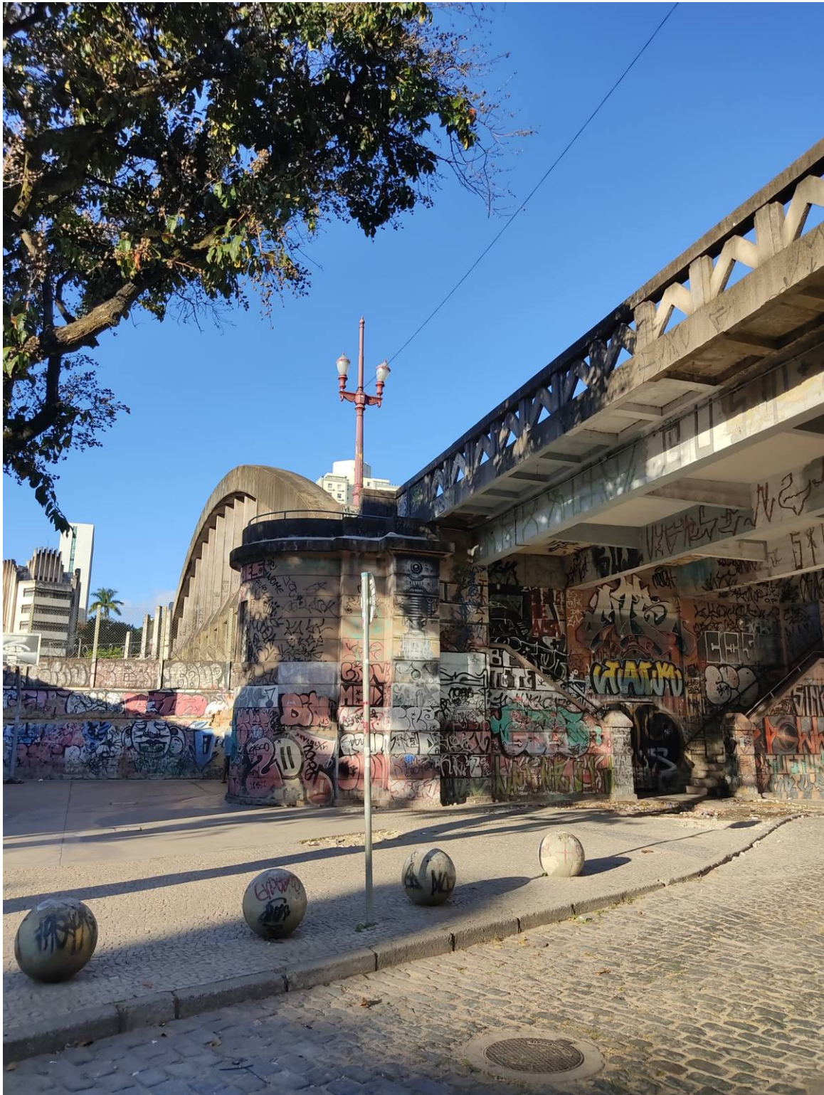
Figura 14 – Viaduto 10 - Ficamos de fora mais uma vez. Fonte: fotografia própria.
