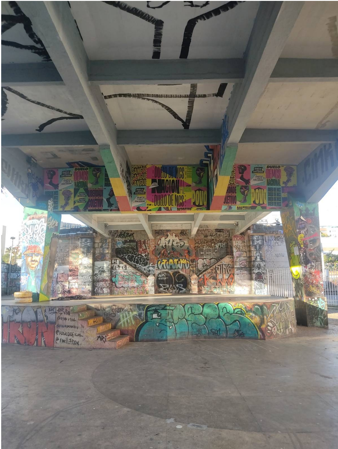
Figura 11 – Viaduto 7 - O palco. Fonte: fotografia própria.
