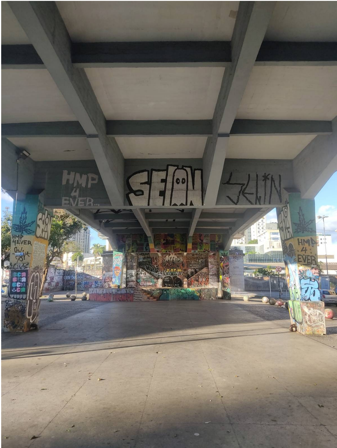
Figura 10 – Viaduto 6 - Legaliza já. Fonte: fotografia própria.
