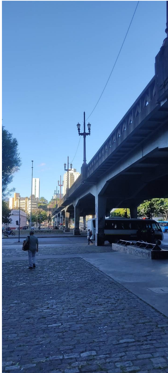
Figura 6 – Viaduto 3 - Polícia Covarde. Fonte: fotografia própria.
