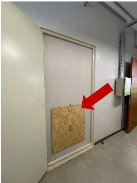
a) Vista do painel móvel com fechamento com placa de OSB para acesso à câmara reverberante
