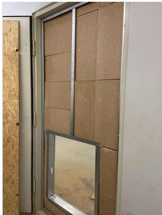
b) Inserção das placas de vermiculita na parede de LSF
