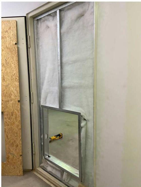
a) Inserção da manta de lã de PET na parede de LSF
