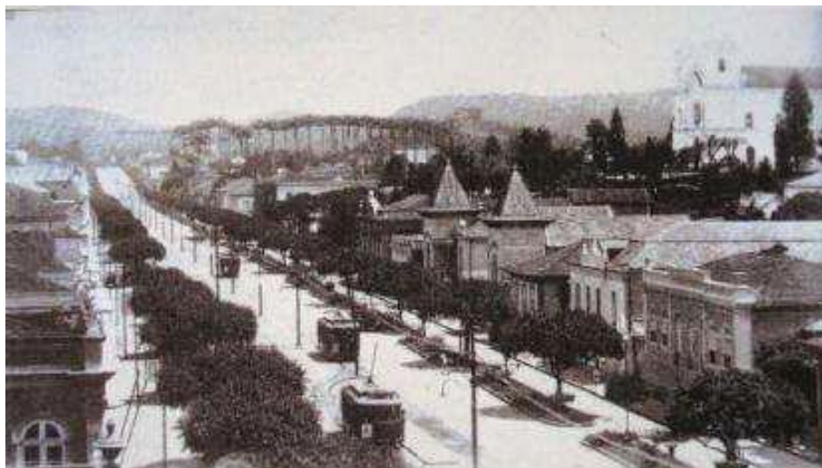
FIGURA 01 - AVENIDA BARÃO DO RIO BRANCO, JUIZ DE FORA EM 1900.
