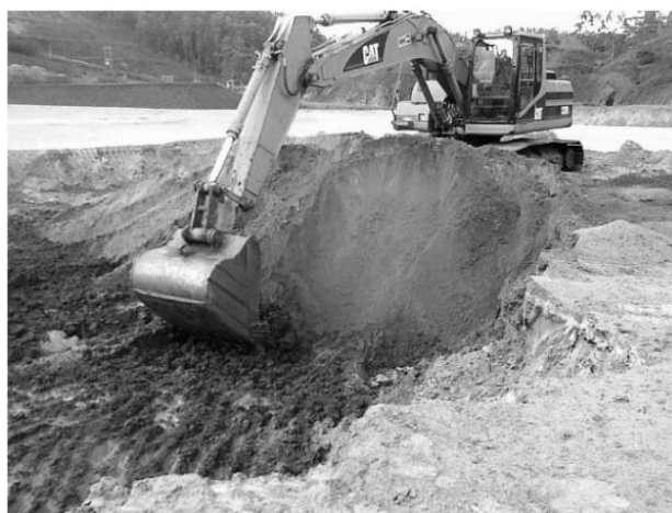
Figura 3.25 – Escavação de camada de rejeito disposto em empilhamento drenado (Pimenta, 2011 apud Portes, 2013).
