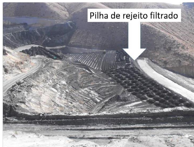
Figura 3.26 – Pilha de rejeito filtrado ( Dry stack ) em operação na Mina Cerro Lindo, Peru (Golder Associates, 2015 apud Alves 2020).
