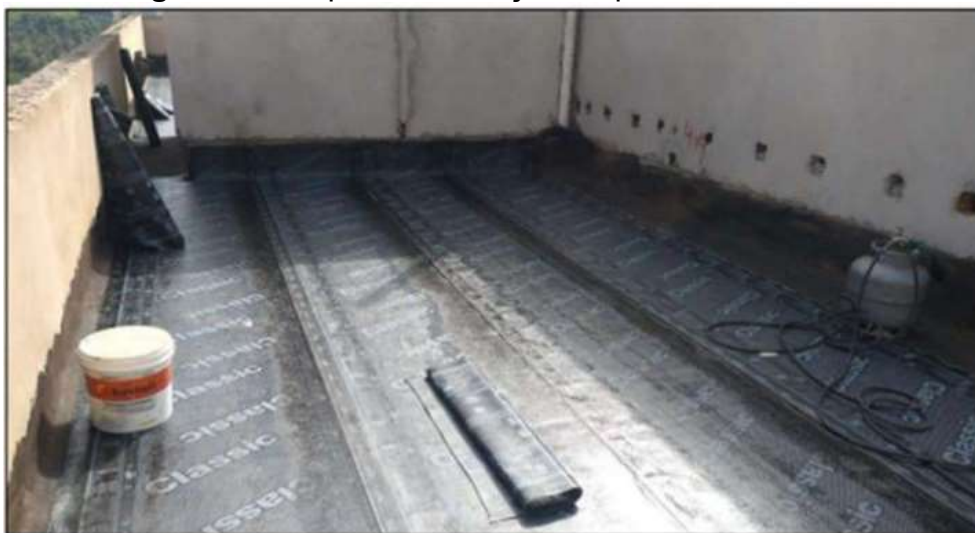
Figura 5-4: Impermeabilização do piso da cobertura.
