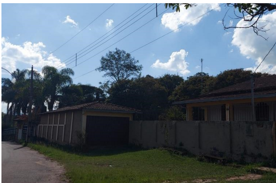
Figura 64 — Localização da antiga casa dos fogueteiros em São Gonçalo do Bação.
