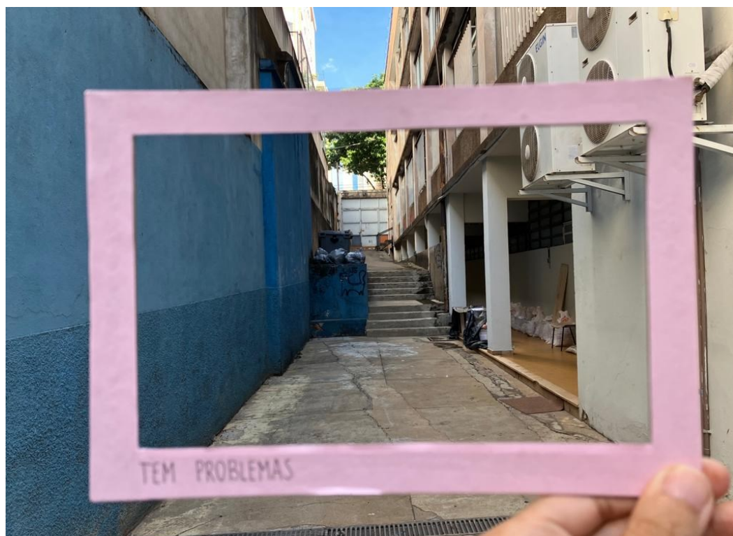
Figura 84 — Foto do corredor dos fundos da Escola de Arquitetura com moldura "tem problemas".
