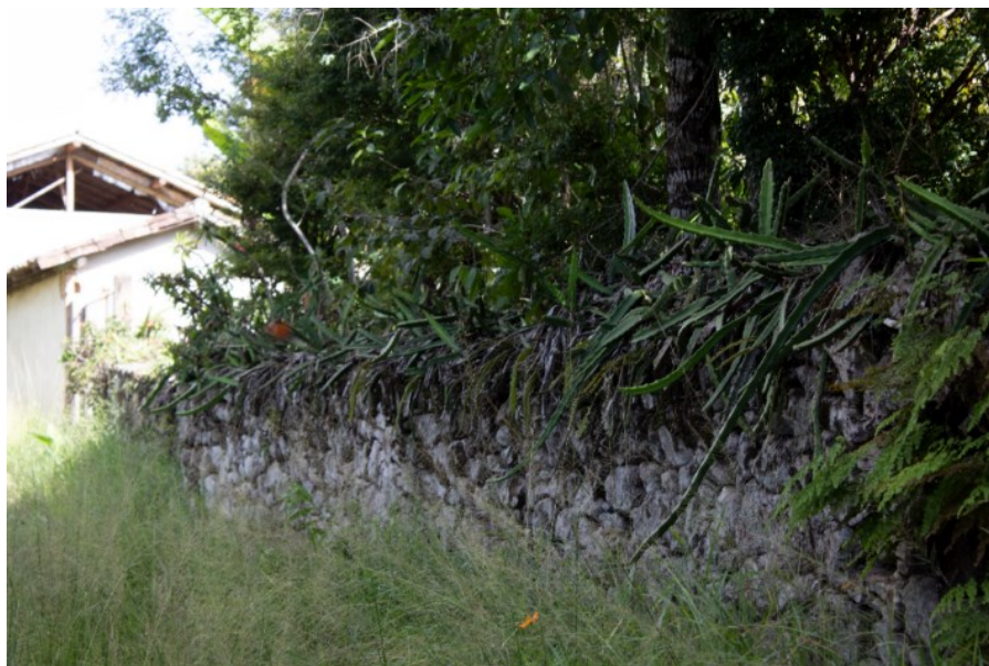
Figura 66 — Muro de pedra em São Gonçalo do Baçõo.
