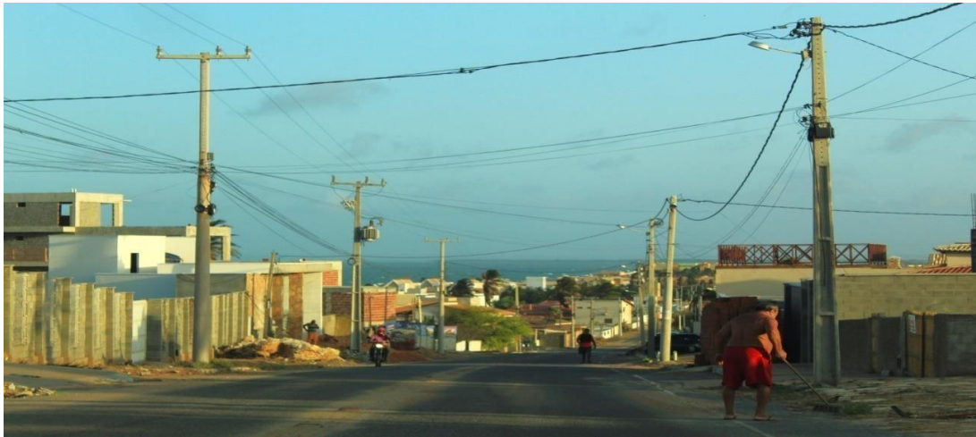
Figura 18 - Entre casas e condomínios em construção
