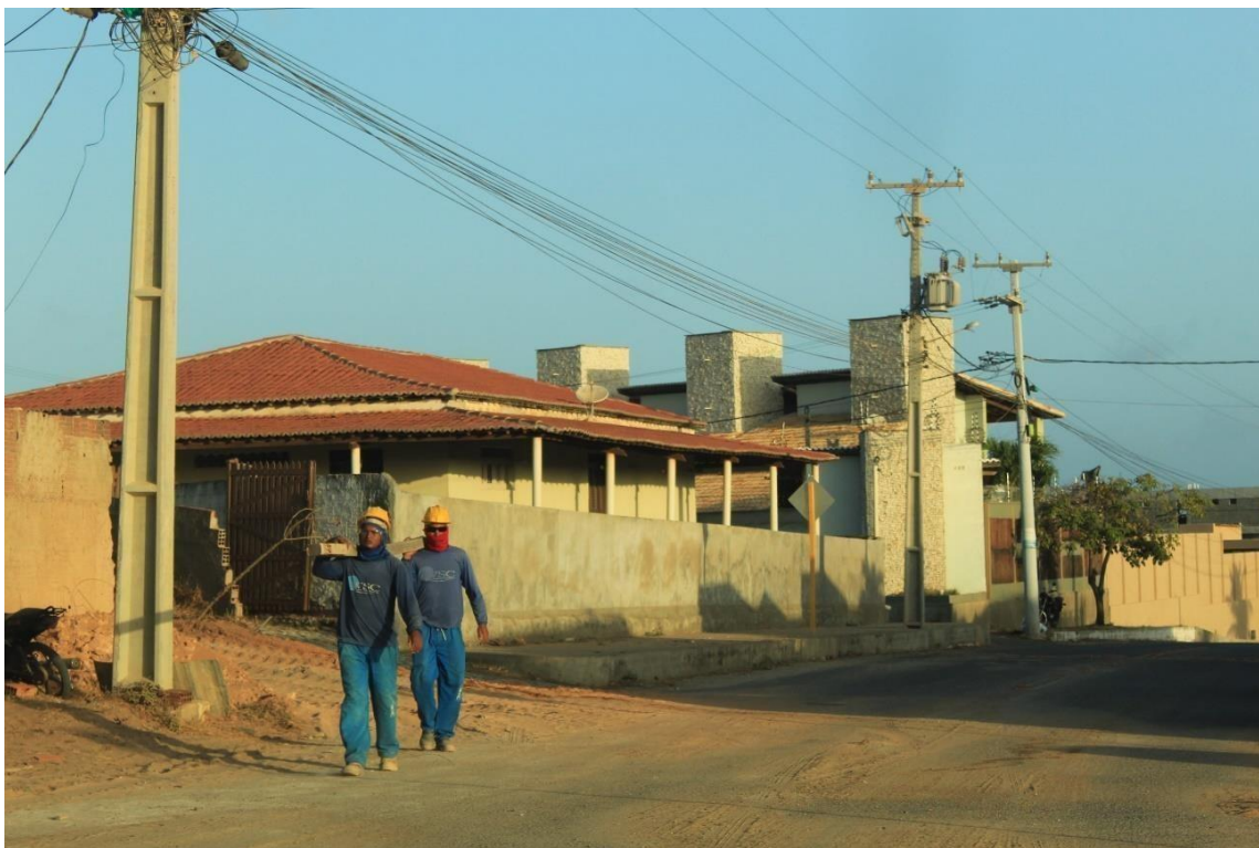
Figura 26 - Área de obras em Tibau
