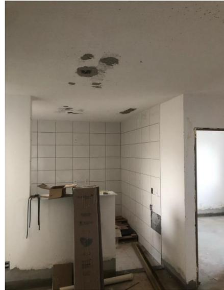
Figura 12b: Aberturas no teto causadas após pintura e deslocamento de azulejo.
