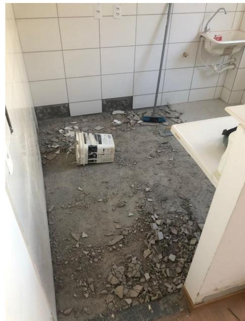
Figura 12d: Troca de cerâmica com má aderência devido a má execução de impermeabilização.
