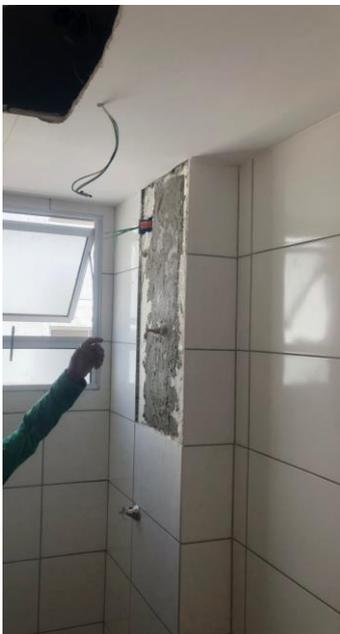
Figura 12c: Reparo de shaft após regularização de ponto hidráulico e corte de forro de banheiro para possível correção hidráulica.
