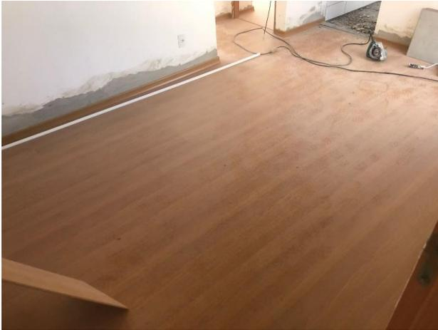
Figura 12a: Mancha no rodapé de laminado devido a irregularidade na parede.
