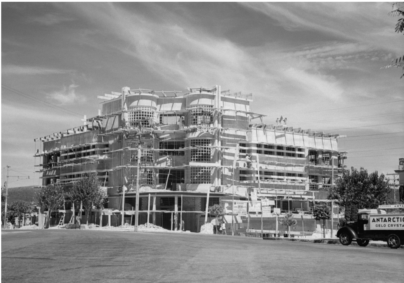
Figura 15 - Minas Tênis Clube, sede em construção.
