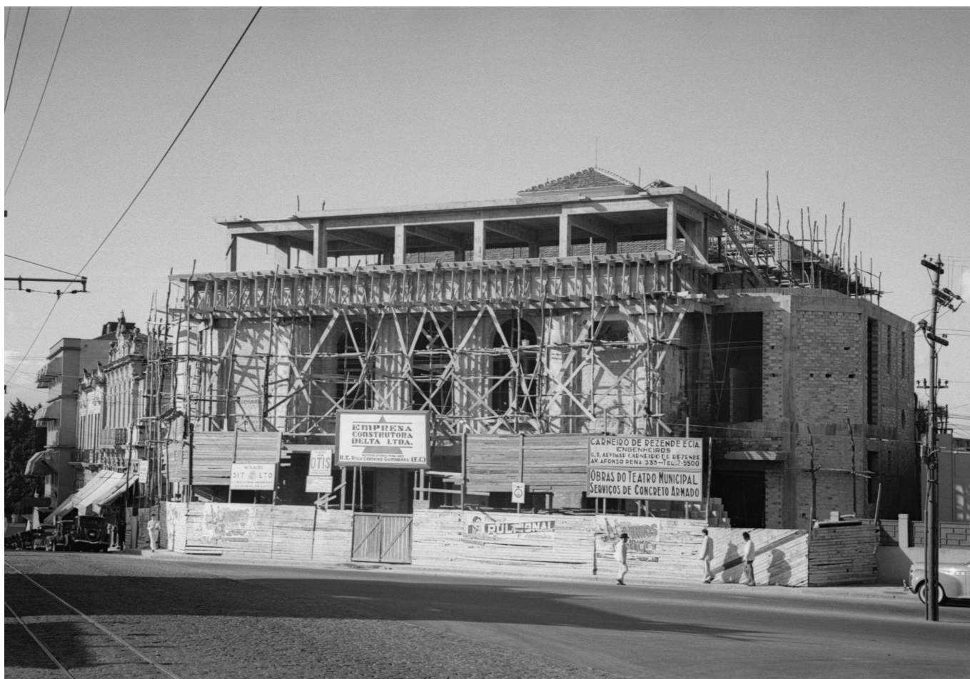
Figura 16 - Reforma do Teatro Municipal (depois Cine Metr pole).
