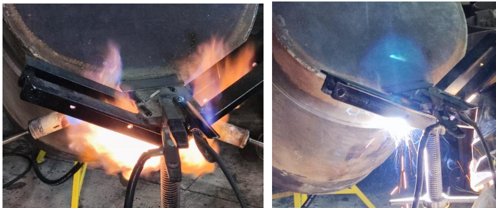
Figura 26 - Etapas de pré-aquecimento e soldagem em ângulo.
