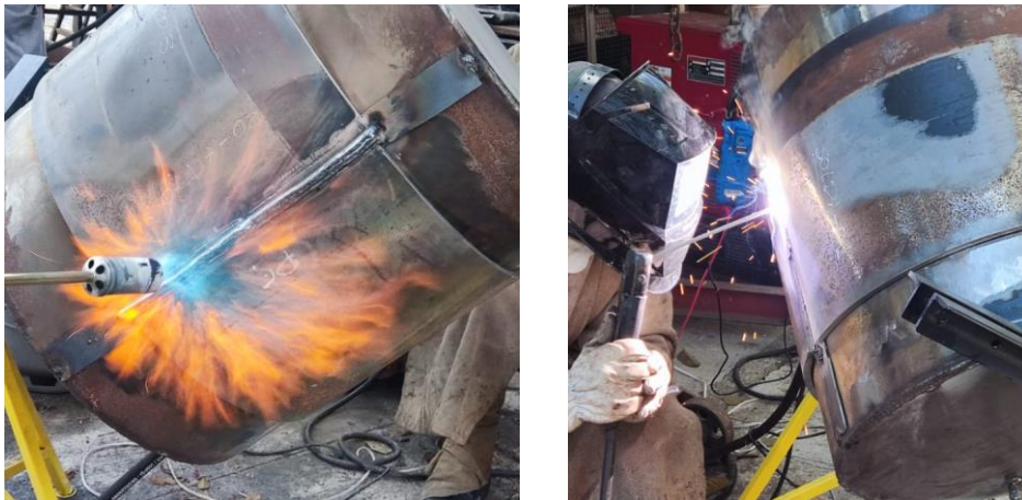
Figura 22 - Pré-aquecimento e controle da temperatura de aquecimento e interpassas da solda longitudinal (solda de chanfro).
