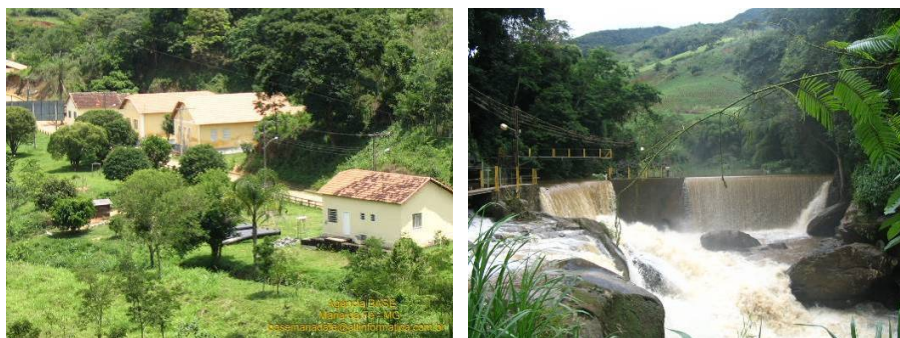
Figura 180: Edificações da Central Luiz Dias e sua queda d'água
