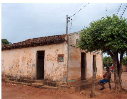
Figura 224: Prédio residencial e comercial situado à Rua Belizário
