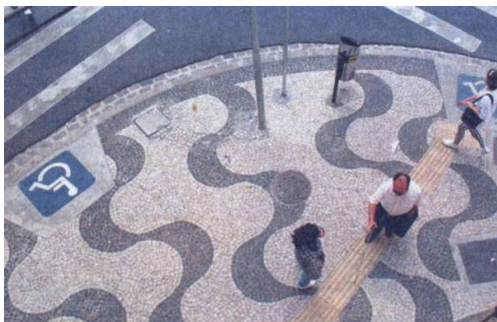
Figura 240: Calle preparada con un piso en alto relieve, aplicado a las aceras, con semáforos especiales para los deficientes visuales
