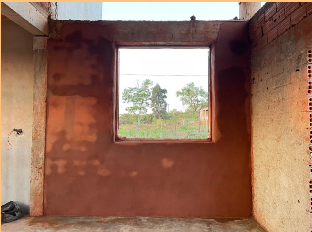
Figura 35 — Reboco de terra recém finalizado, em processo de secagem.
