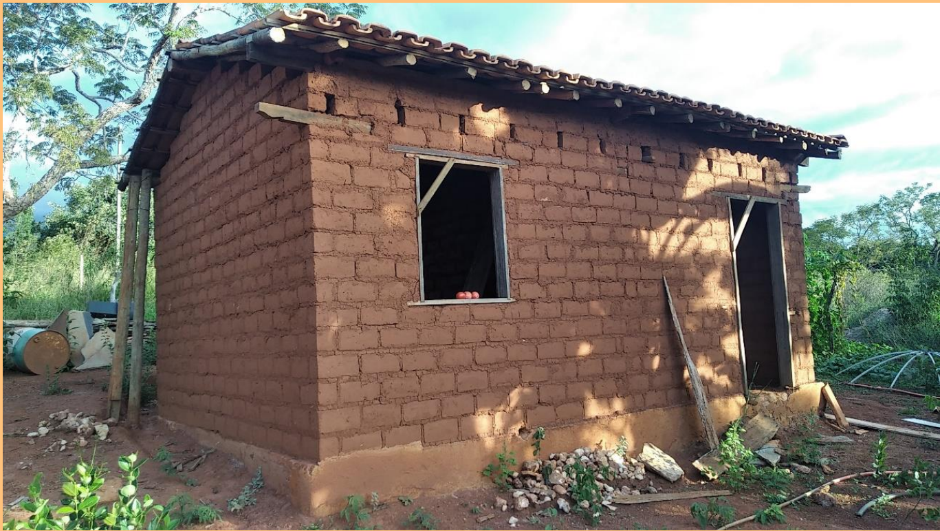
Figura 19 — Barracão em construção por Enéas.
