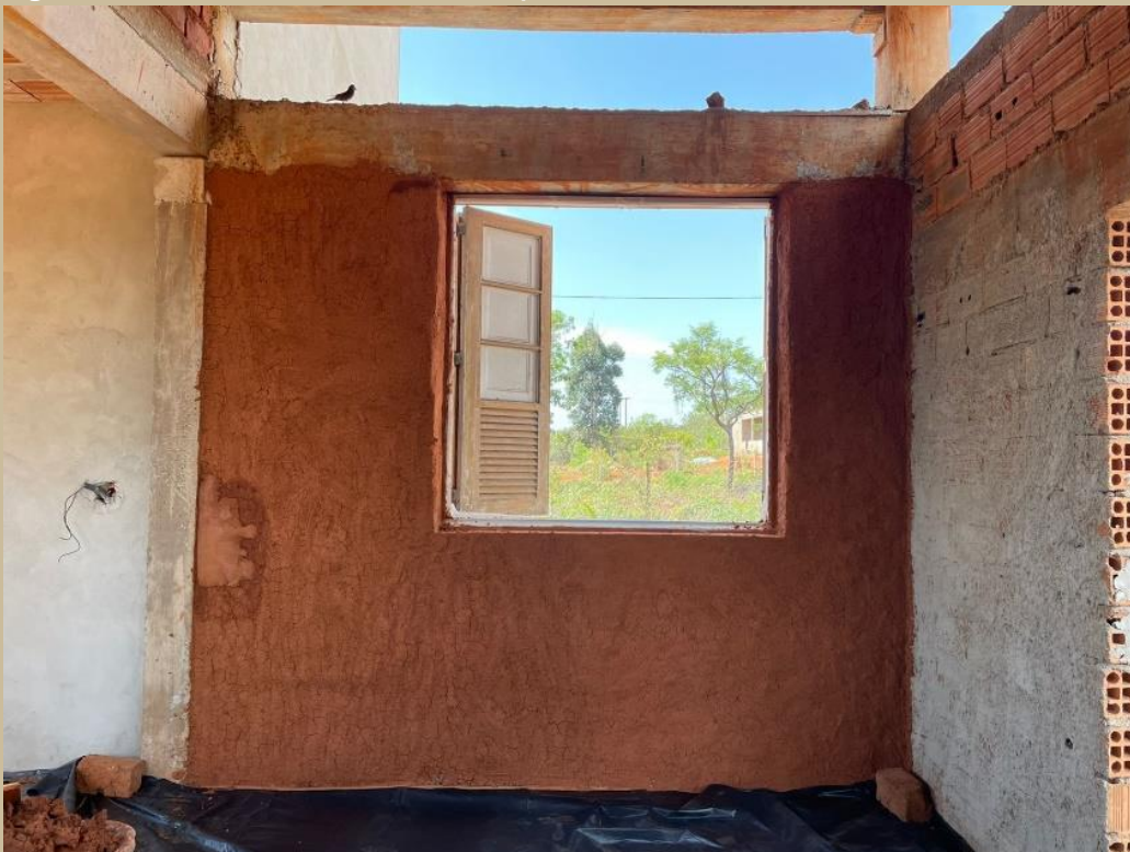
Figura 33 — Parede de adobes com chapisco de terra.
