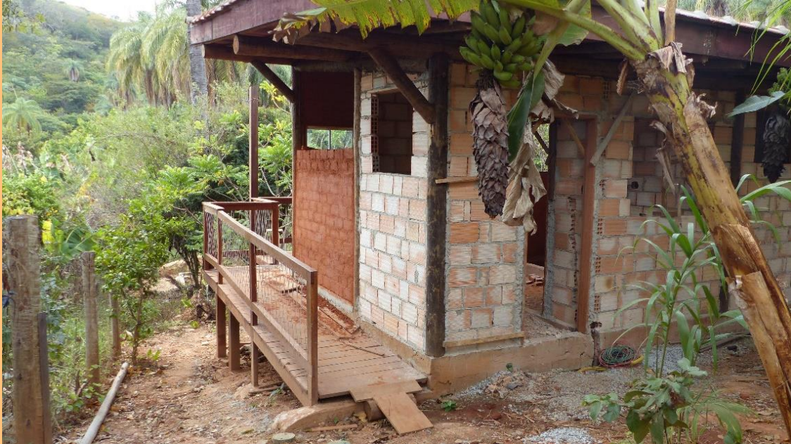
Figura 29 — Chalé Teixeira em construção, com áreas molhadas em alvenaria convencional.
