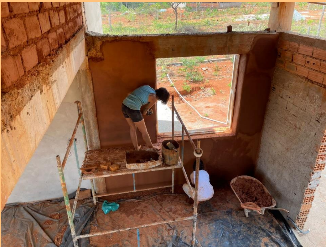
Figura 34 — Execução de um reboco de terra.
