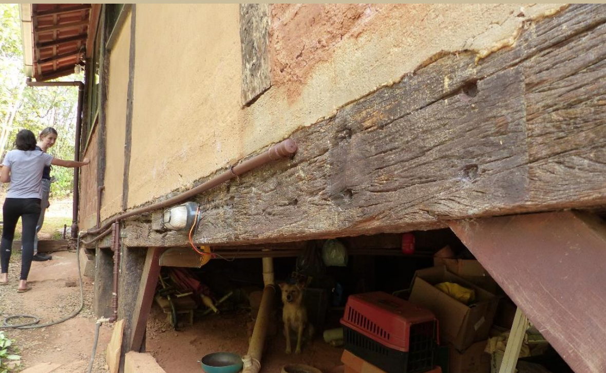
Figura 28 — Casa Suspensa, construída sob madeiras de demolição.
