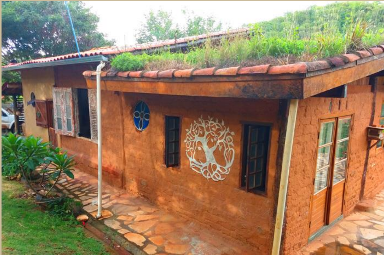
Figura 27 — Casa construída com adobes de demolição e teto verde na Fazenda Alicerce Vivo.
