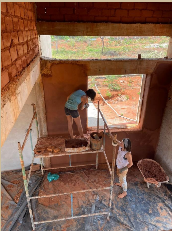
Figura 5 — Lívia e Iara na execução de um reboco de terra.
