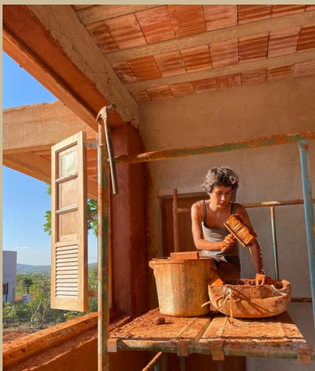
Figura 6 — Clara na execução de um reboco de terra.
