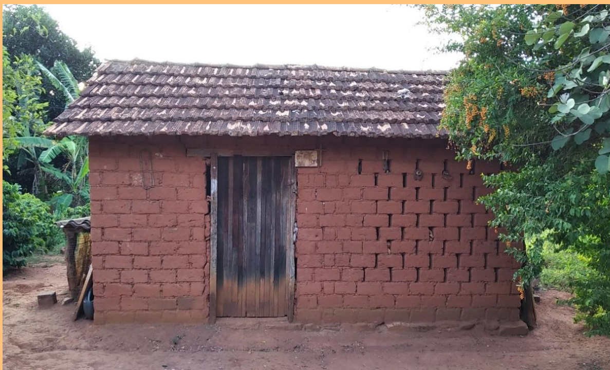
Figura 17 — Depósito construído por Enéas, com cobogó de adobes.
