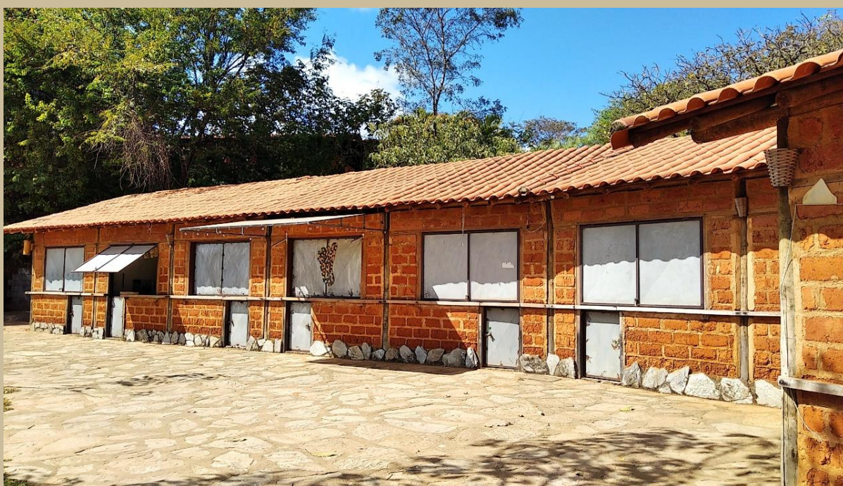
Figura 15 — Quiosques construídos com adobes.
