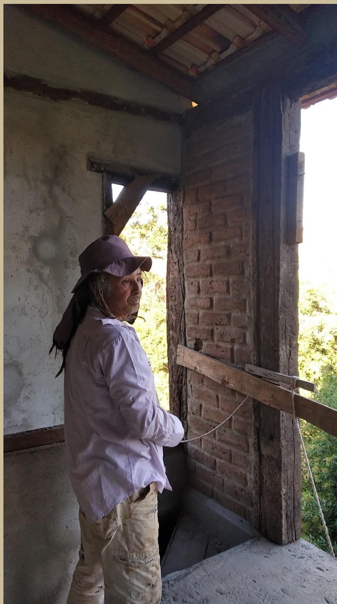
Figura 4 — Zezessantos apresenta uma obra mista em andamento na Lapinha.
