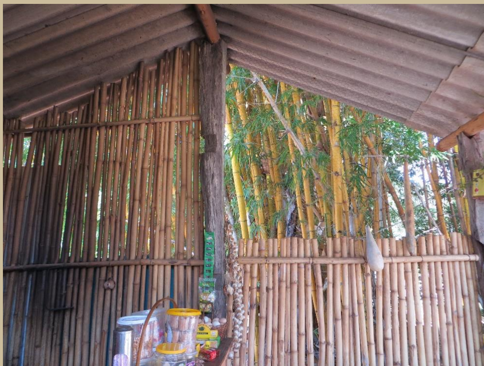
Figura 12 — Vedação de bambu.
