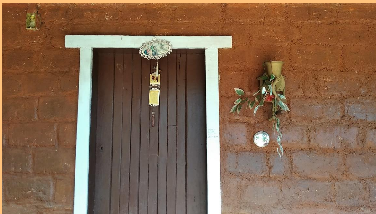
Figura 26 — Fachada principal da casa de Enéas e família, com parede de adobes cujo revestimento de reboco cimentício foi removido.
