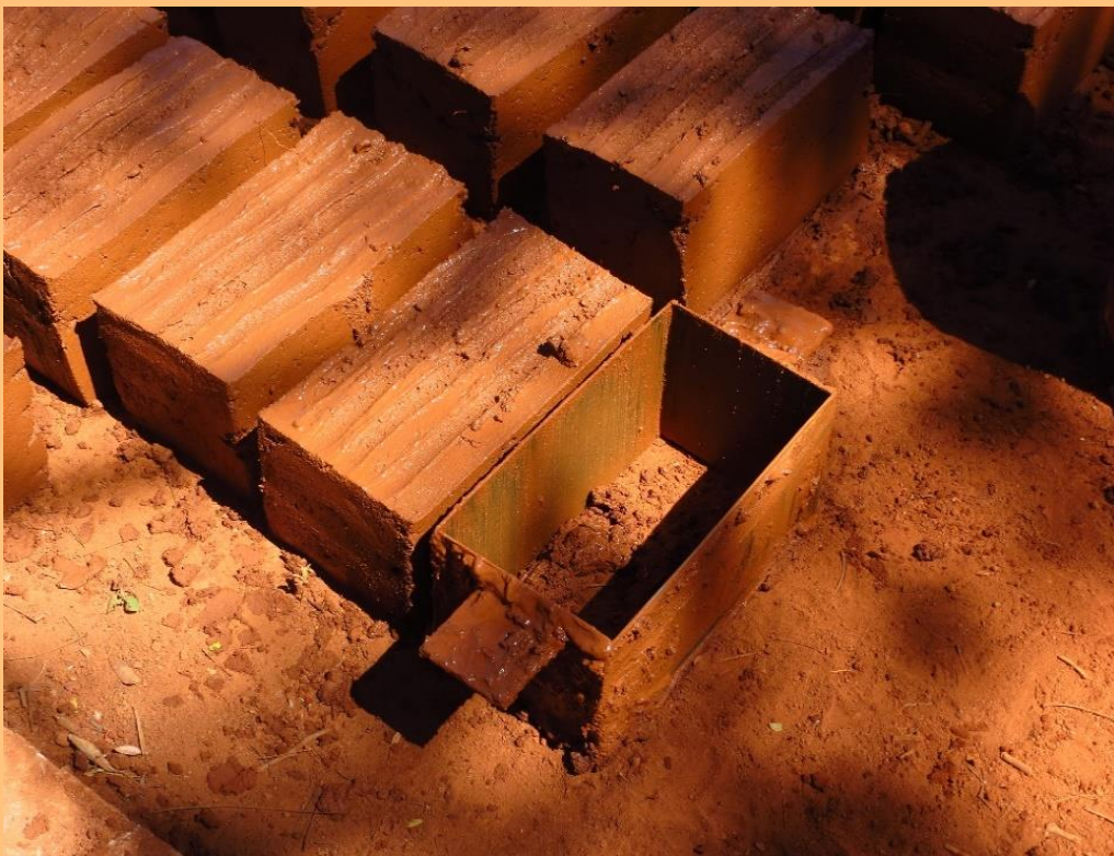
Figura 24 — Fôrma metálica utilizada para a produção do adobe.
