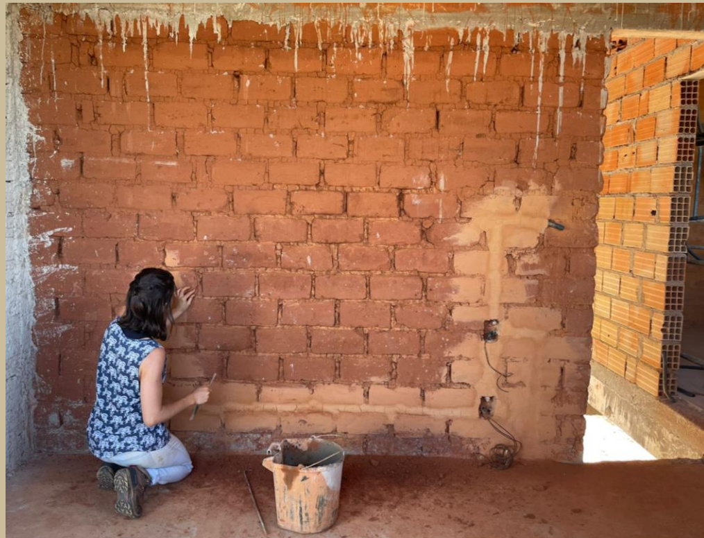
Figura 31 — Trabalho de regularização dos adobes.
