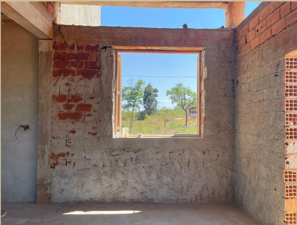
Figura 32 — Parede de adobes com chapisco de cimento.
